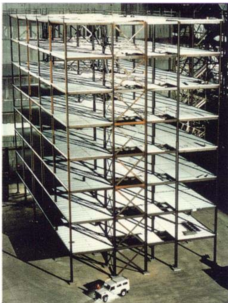
Figura 2.1 – Edifício de oito andares em Cardington
