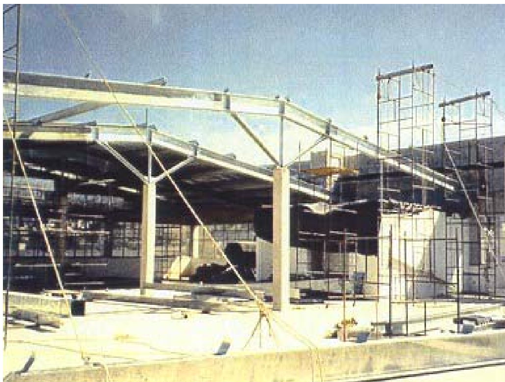
FIGURA 1.3 – Fábrica da ALCATEL - São Bernardo do Campo – SP.
