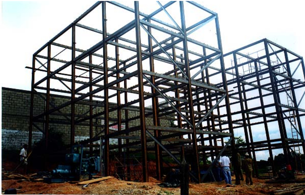
FOTO 1.2 – Estrutura dos edifícios COHAB - MG, 4 pavimentos
