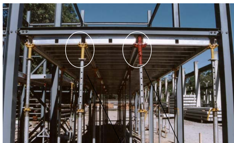
Figura 4.12 – Escoramento removível e “ drop head ”
