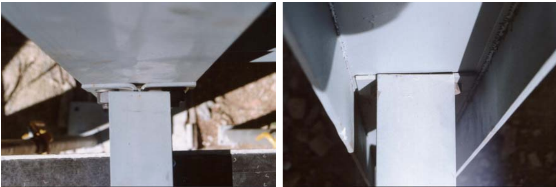
Figura 4.7 – Ligação viga-pilar (vista superior)
