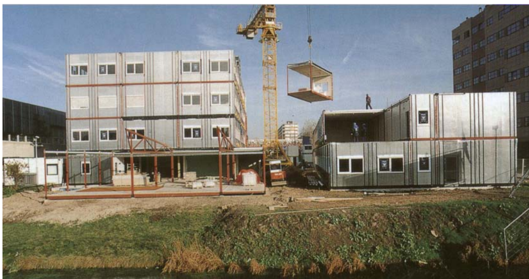
Figura 2.6 – Construção modular, semi industrializada [12]
