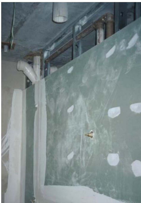
Figura 7.4 – Detalhe chapas especiais para banheiro
