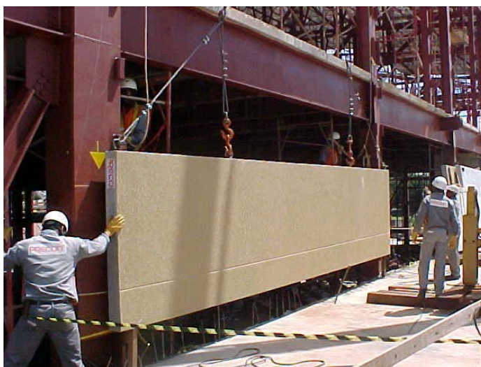
Figura 6.3 - Pannel misto com isolamento
