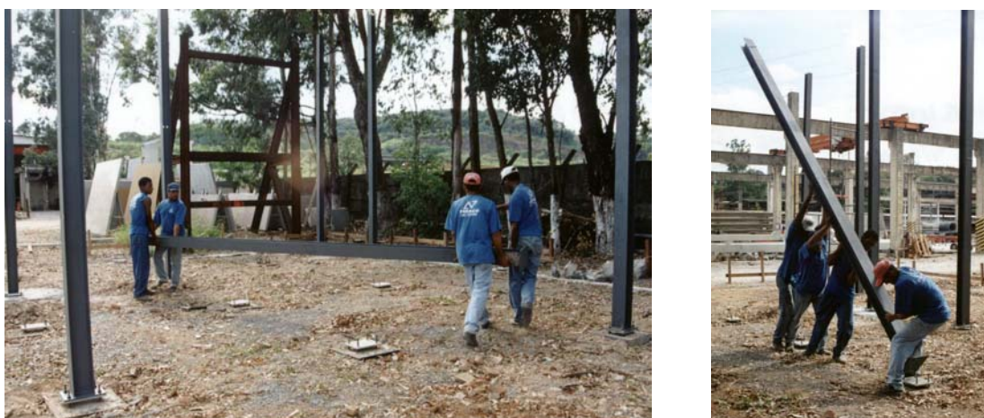
Figura 4.17 – Montagem da estrutura
