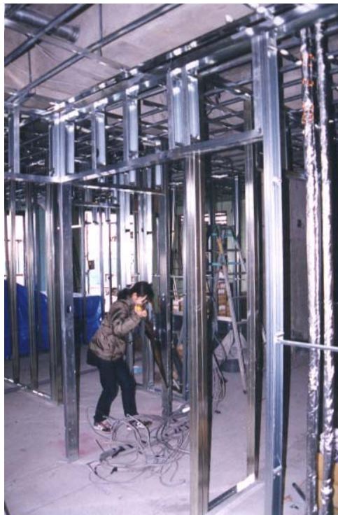
Figura 7.3 – Vista interna de uma obra
