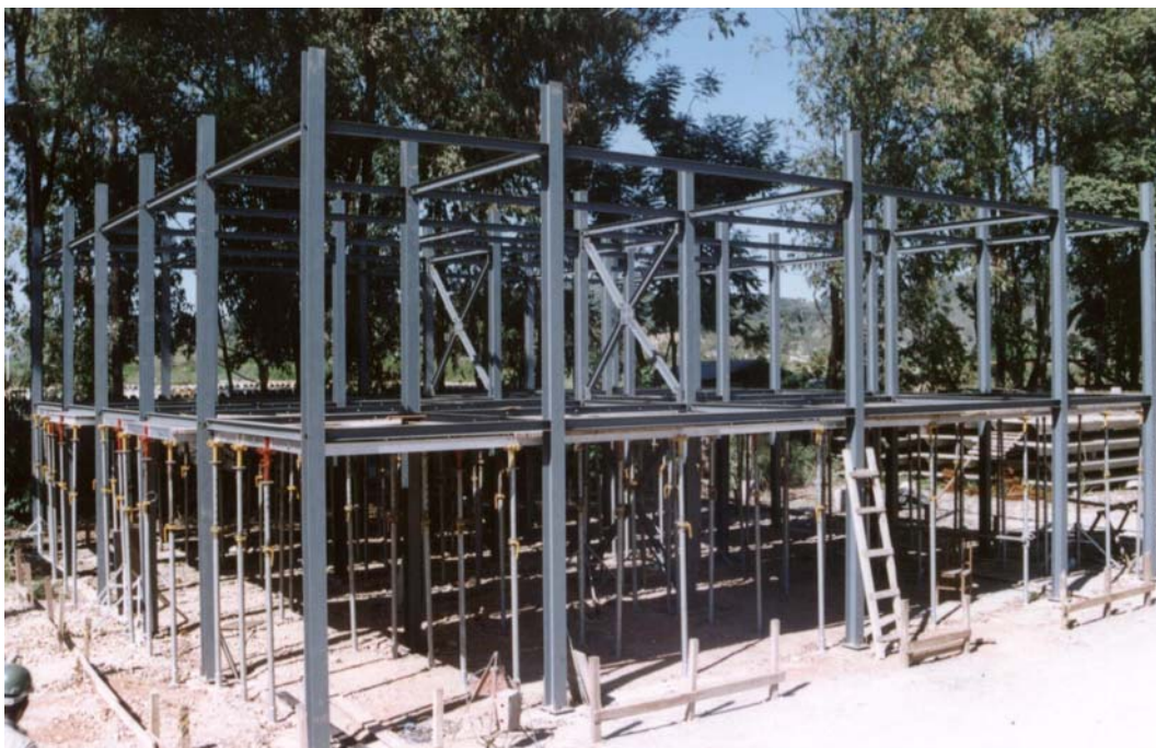
Figura 4.18 – Vista geral da estrutura com forma já executada
