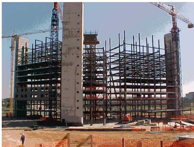
Figura 2.7 - Estrutura metálica estabilizada por núcleo de concreto [11]
