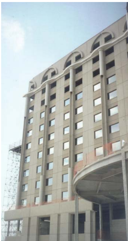
Figura 2.9 - Fachada em painel pré-moldado de concreto [11]
