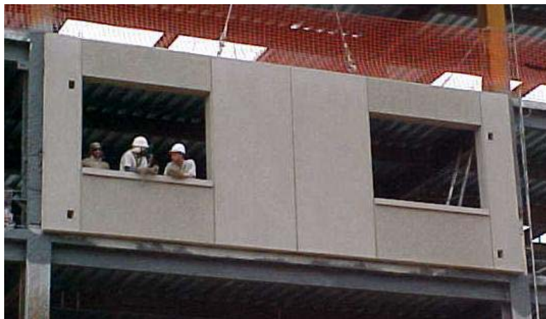
Figura 6.2 - Pannel maciço, sem isolamento
