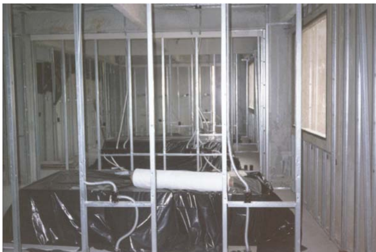
Figura 2.10- Sistema divisórias em gesso acartonado [11]
