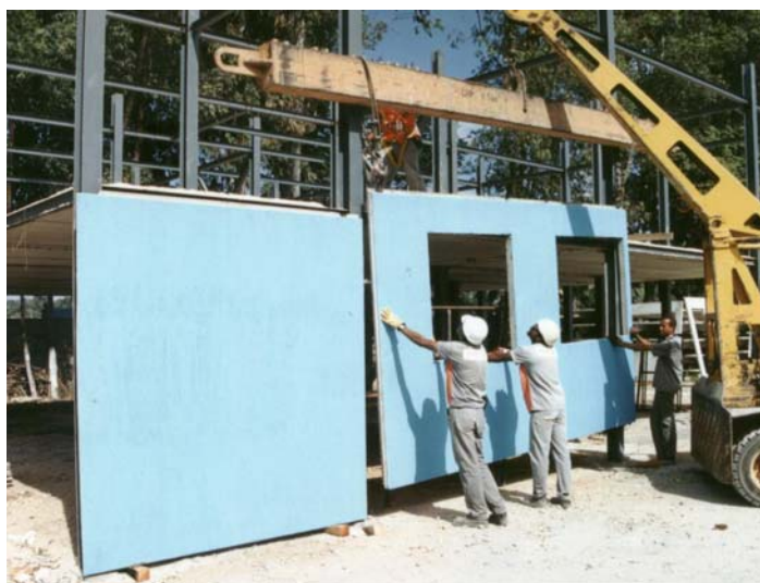
Figura 4.14- Montagem dos painéis
