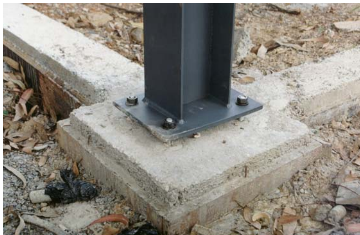
Figura 4.8 – Vista das fundações
