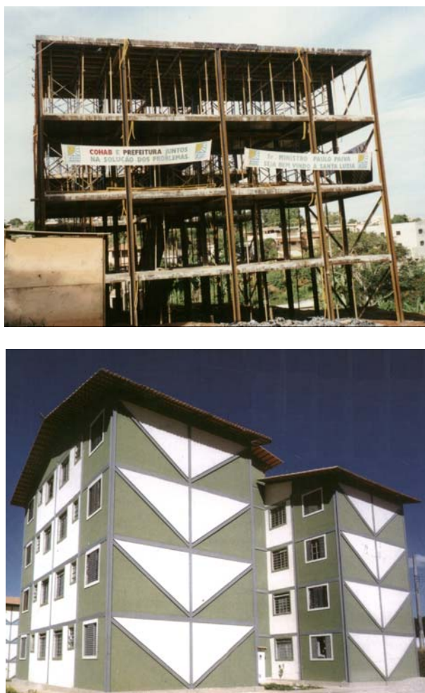
Figura 3.3- Estrutura do edifício COHAB-MG
