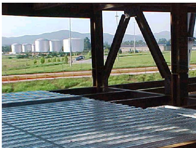
Figura 2.8- Laje com forma metálica incorporada [11]
