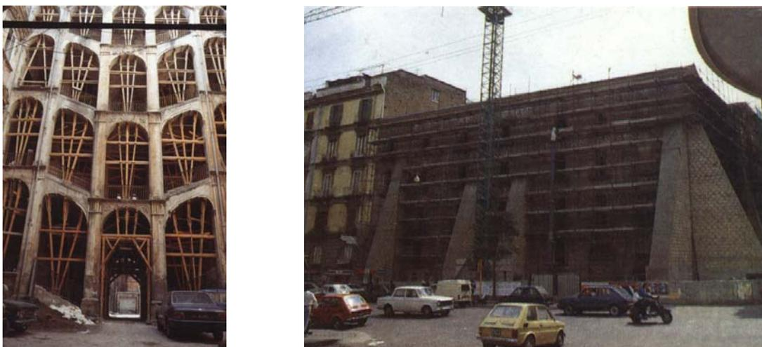
FIGURA 5.1 – Materiais utilizados para escoramento. Na figura da esquerda, o uso de pontaletes de madeira. Na da direita, emprego do contraforte de sustentação em pedra.
