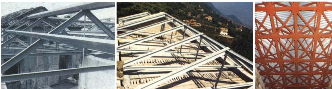
FIGURA 5.28 – Estruturas de madeira substituídas por aço.
