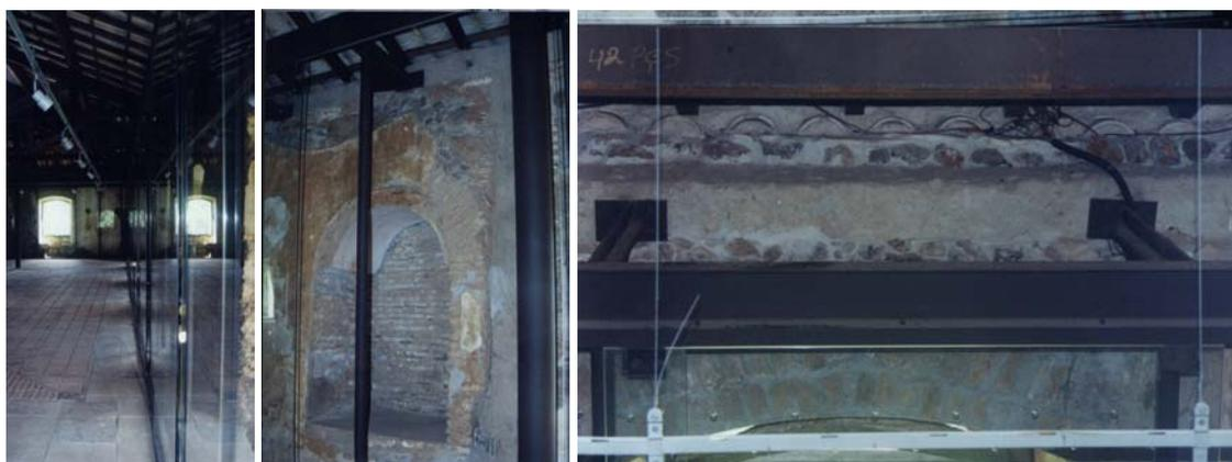
FIGURA 6.11 – Painéis em vidro temperado protegendo a alvenaria instalados com a estrutura de sustentação metálica.
