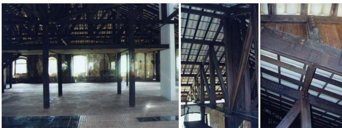
FIGURA 6.10 – Mezanino em estrutura metálica e sustentação da cobertura em estrutura mista de madeira e aço.
