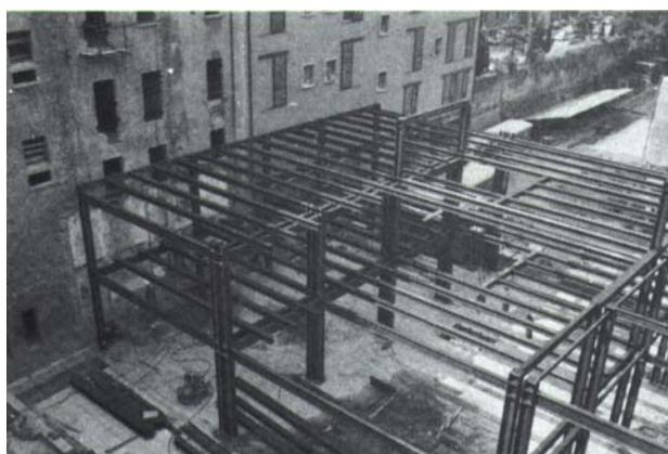
FIGURA 4.5 – Nova estrutura portante em aço do corpo interno.
