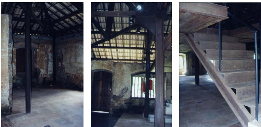
FIGURA 6.12 – Pilares metálicos em aço SAC 41 e pilares do mezanino compostos por perfis I.
