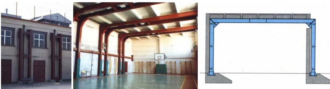
FIGURA 5.42 – Transformação de edifício industrial em ginásio.
