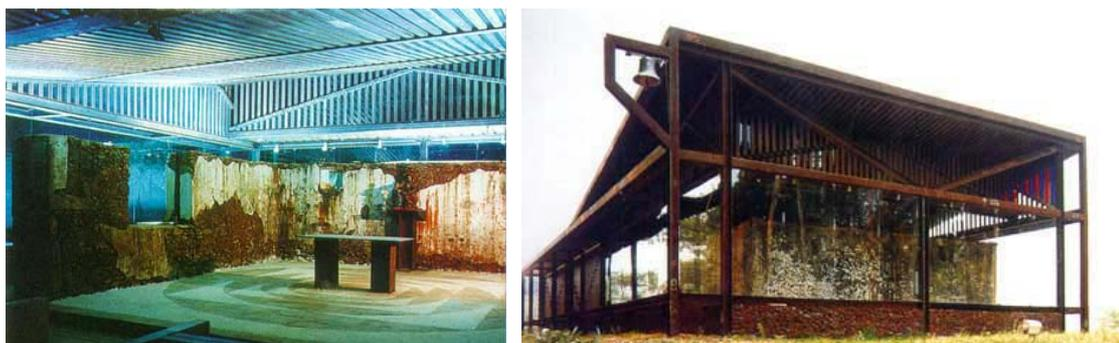
FIGURA 6.18 – Altar e a estrutura metálica com painéis de vedação em vidro temperado.
