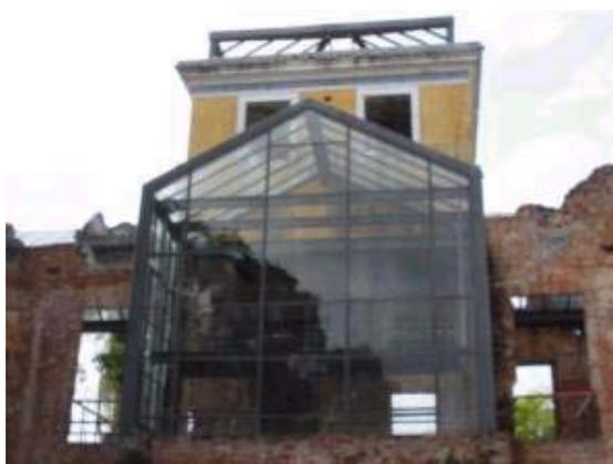
FIGURA 6.5 – Recuperação do mirante e piso criado dando espaço a um terraço com uma vista livre e cobertura transparente.
