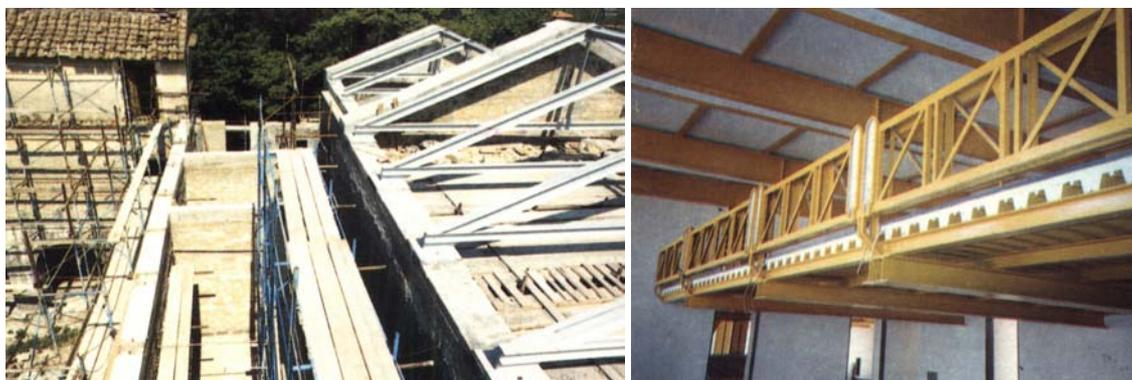
FIGURA 4.1 – Exemplos de consolidação com o aço na substituição de coberturas, reforço estrutural e reestruturação de antigas estruturas.
