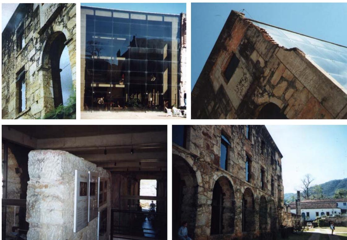
FIGURA 6.22 – Intervenção com concreto realizada no edifício incendiado.
