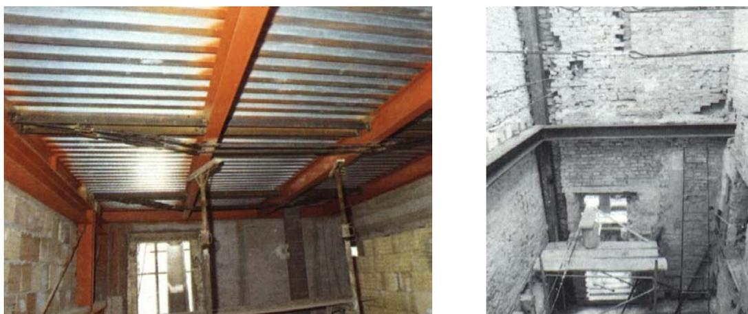
FIGURA 4.11 – Novo teto em aço e nova estrutura metálica adotada para sustentar as estruturas intermediárias e de cobertura.
