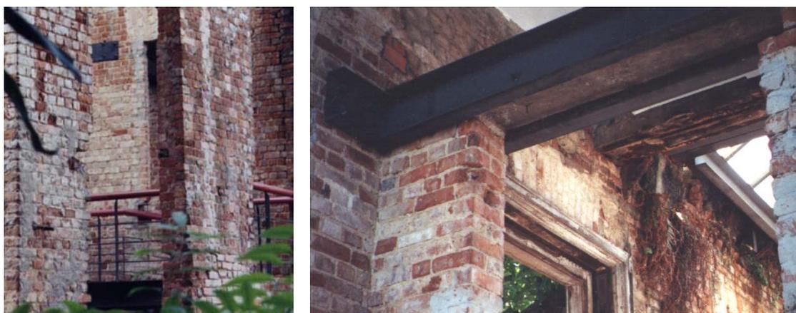
FIGURA 6.7 – Ligações parafusadas unindo a estrutura metálica à estrutura.
