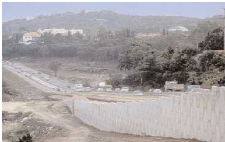
FIGURA 1.9 – Contenção Lateral para Alargamento de Autopista em Portugal
