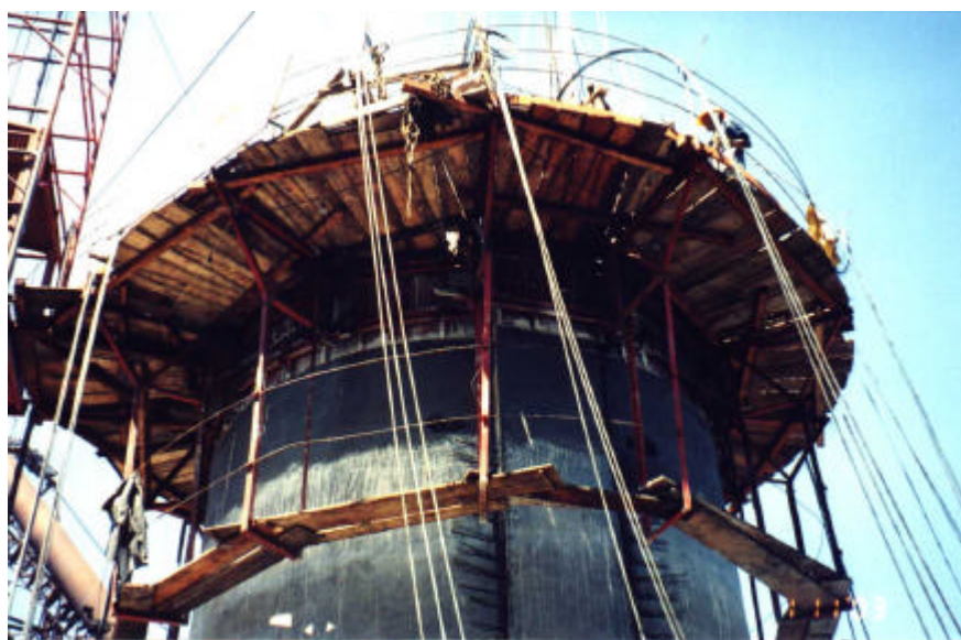
FIGURA 1.4 – Reservatório em Execução – Matosinhos-MG
