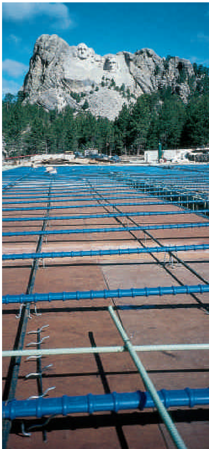
FIGURA 2.22 – Laje com Protensão Aderente – Monte Rushmore – Keystone, SD, USA
