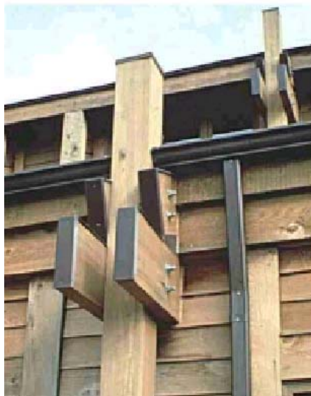
FIGURA A27 – Proteção das extremidades de vigas e pilares expostos Fonte: AF&PA - The Wood Connection Session, 2002, p. 33.
