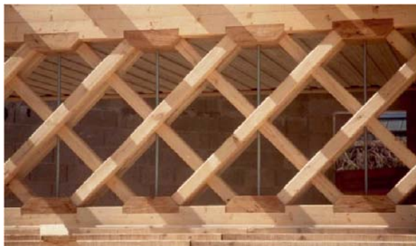
FIGURA 10 – Berços ligados por contato (Canal em Oyonnax) Fonte: FLACH e FRENETTE, 2000.
