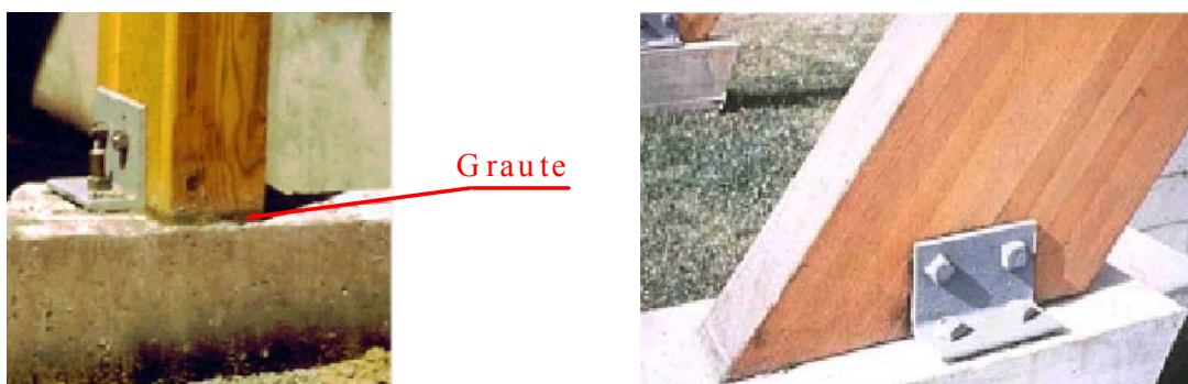
FIGURA A24 – Extremidades em contato com concreto Fonte: AF&PA - The Wood Connection Session, 2002, p. 56 e 62.
