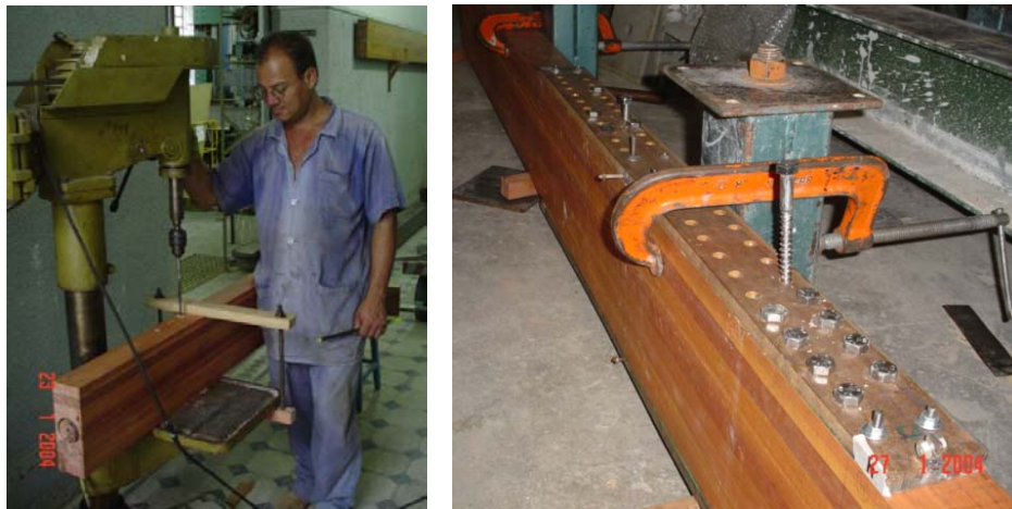
FIGURA 47 – Execução dos furos e inserção dos parafusos
