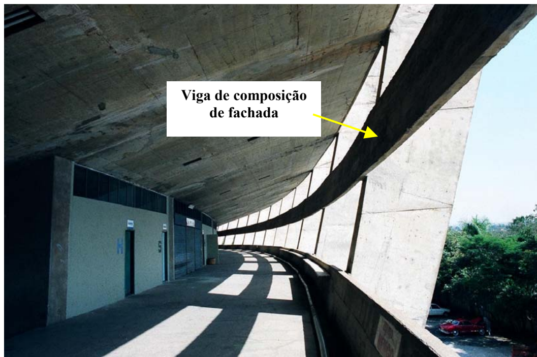
FIGURA 3.8 – Foto com a identificação da viga da composição da fachada
