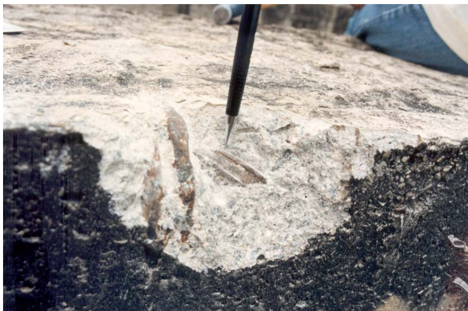
FIGURA 3.93 – Foto de viga de cobertura do pórtico central escarificada, para a pesquisa do grau de corrosão das armaduras
