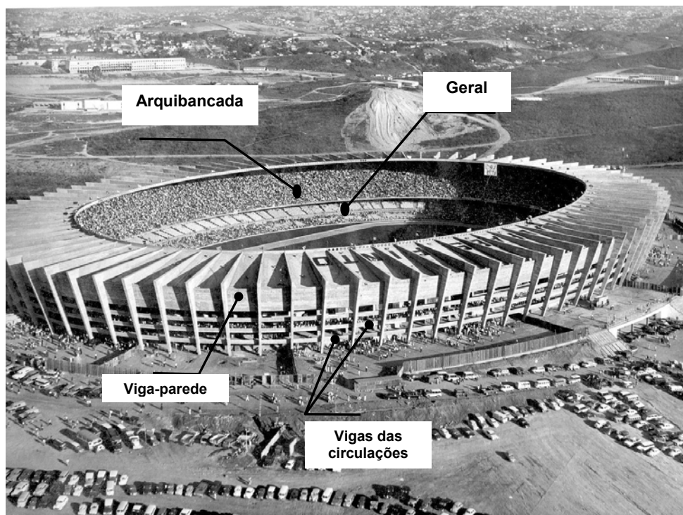
FIGURA 2.90 - Vista aérea do Estádio Magalhães Pinto, onde se vêem os pilares externos, as duas circulações e as vigas-parede na parte superior fazendo a ligação entre os pórticos
