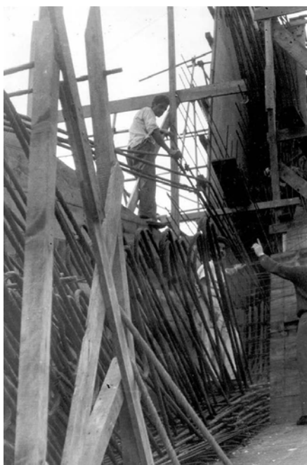
FIGURA 2.106 – Armações, ainda incompletas, de uma viga da arquibancada na região próxima ao pilar externo
