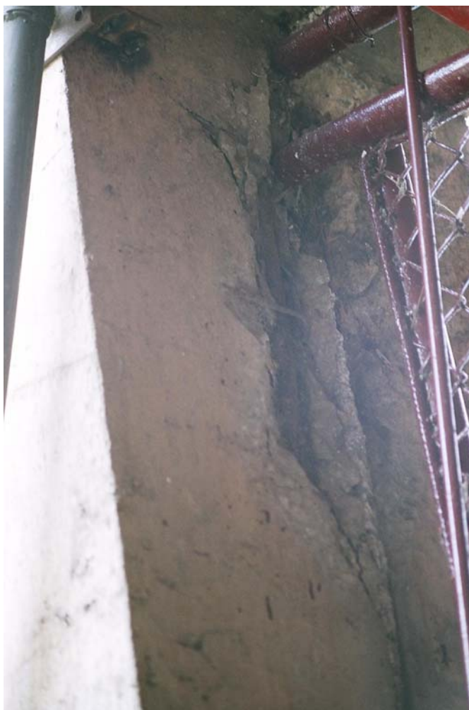
FIGURA 3.30 – Fixação de alambrado na armação do pilar externo
