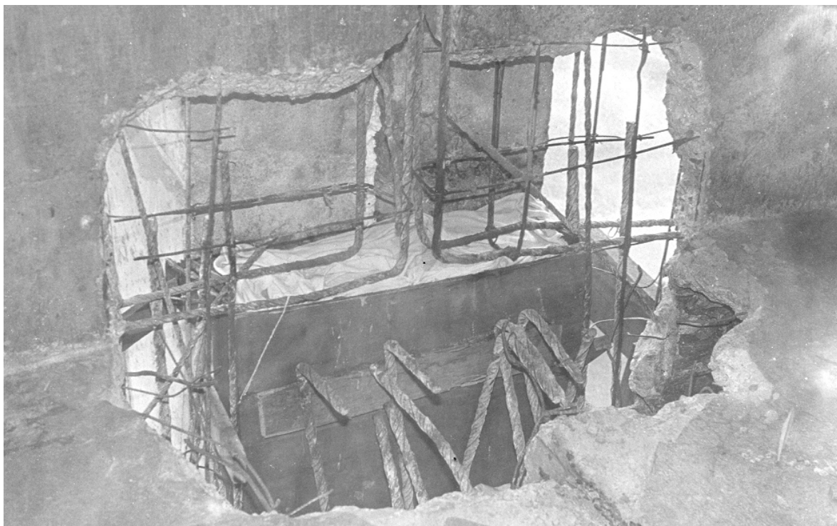
FIGURA 3.71 - Fotografia da ocasião da recuperação dos consolos da circulação Fonte: Administração dos Estádios de Minas Gerais (ADEMG), 1986.
