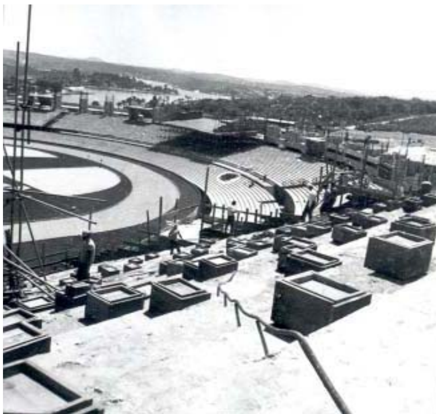
FIGURA 3.110 – Fotografia dos caixotes de areia colocados sob o escoramento metálico
