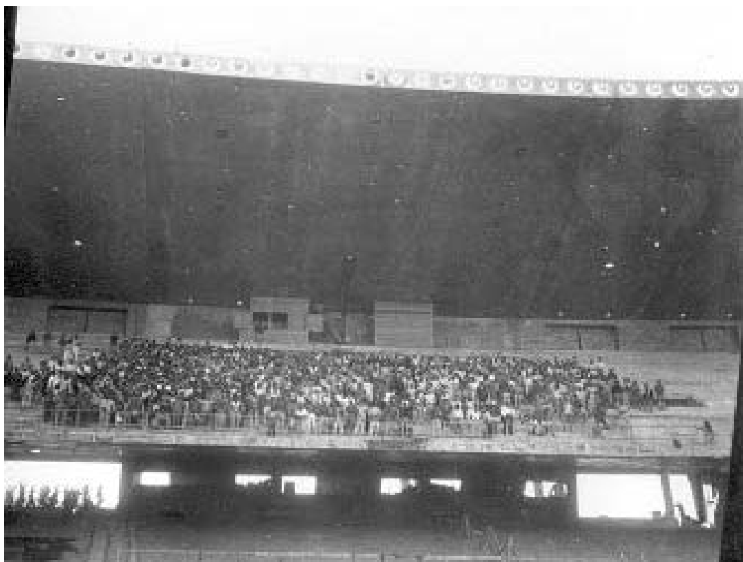
FIGURA 3.104 – Fotografia documentando a prova de carga realizada no setor 15, após a alteração da estrutura. Observar que nessa ocasião a cobertura já estava concluída
