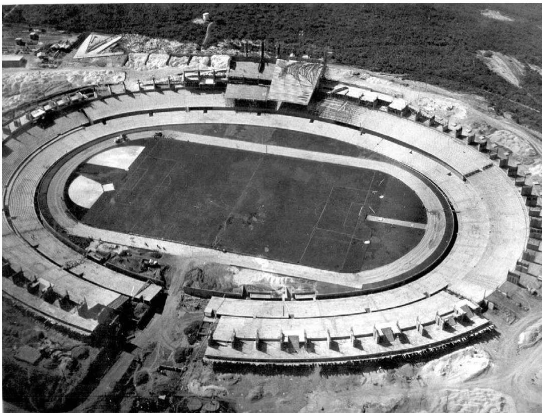
FIGURA 3.100 – Fotografia aérea do Mineirão em construção com a arquibancada do setor 15 já concretada e a forma da arquibancada do setor 16 sendo executada
