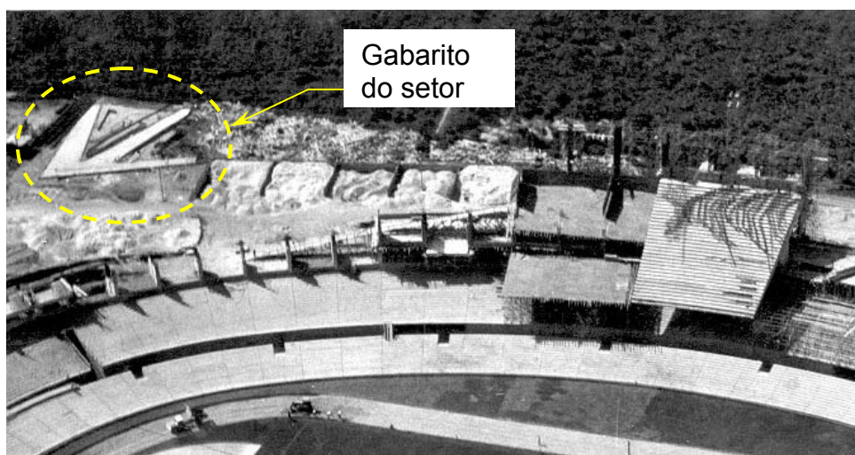
FIGURA 3.94 – Fotografia aérea mostrando o setor 15 (à direita) com a estrutura da arquibancada pronta, o setor 16 com a forma em execução e, no canto superior esquerdo, o gabarito que serviu para alojar e verificar o posicionamento do aço dobrado do setor 15
