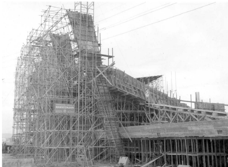
FIGURA 3.96 – Vista lateral externa da montagem da forma e do escoramento do pilar externo e viga da arquibancada
