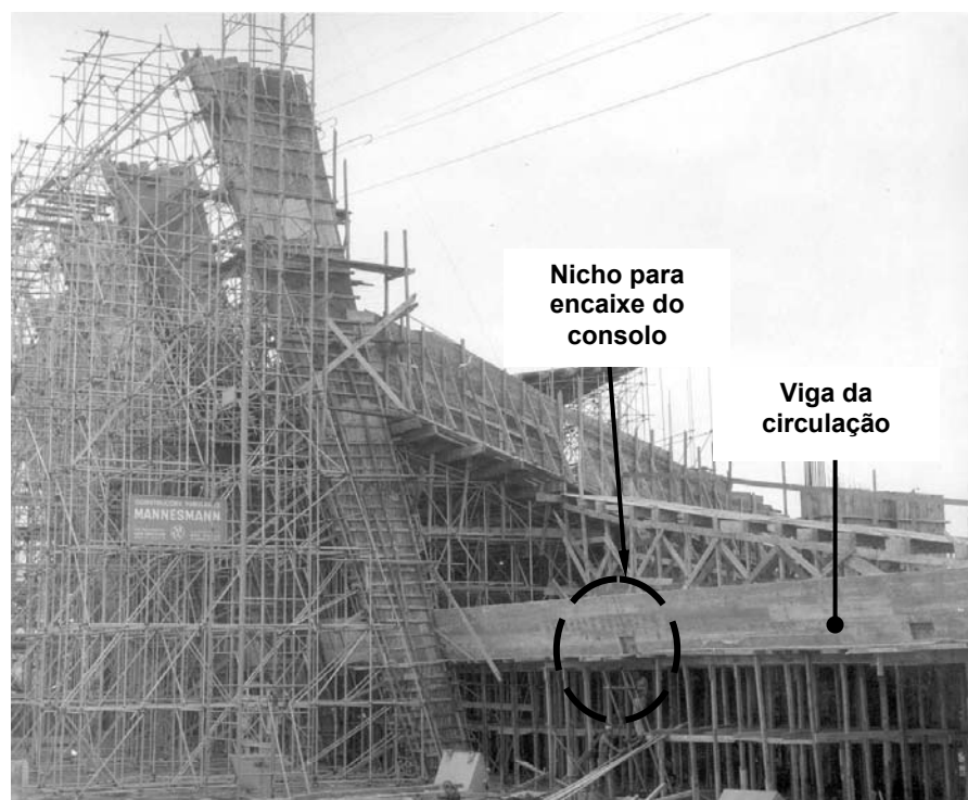
FIGURA 2.114 – Estrutura da circulação superior já concretada, aguardando a execução do pilar externo e da estrutura da arquibancada. Em destaque é mostrado o nicho para encaixe do consolo da pilar externo
