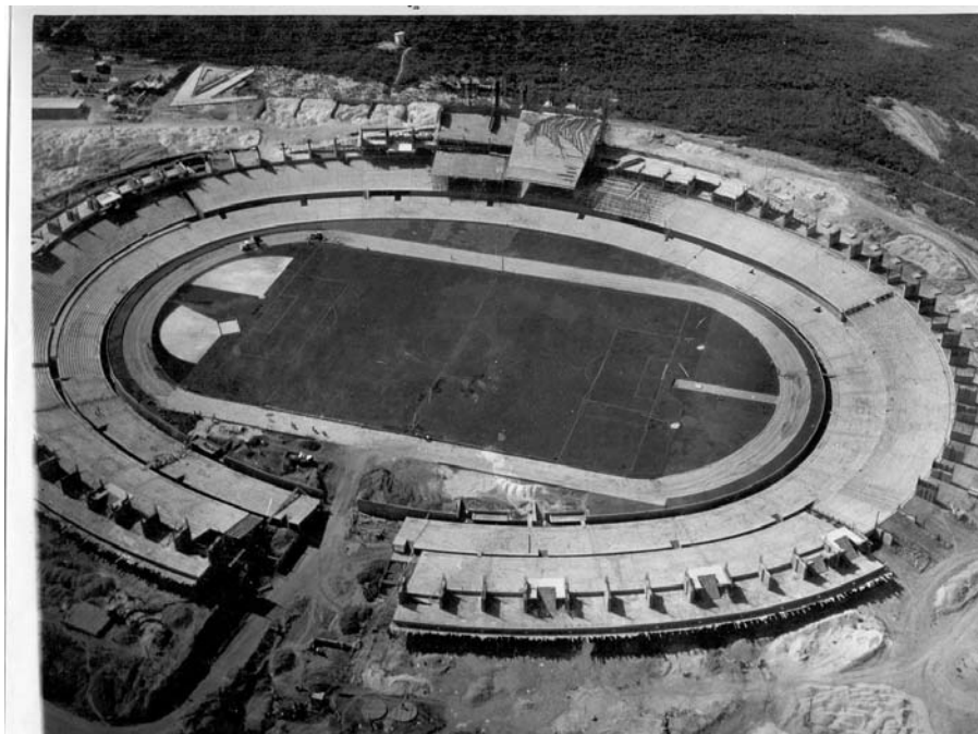
FIGURA 2.91 - Vista aérea do Estádio Magalhães Pinto, com grande parte da fundação executada, o setor 15 com a arquibancada concretada e, ao lado dele, o setor 16, com apenas a forma da arquibancada pronta
