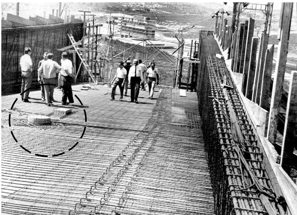
FIGURA 2.110 – Armações da viga e laje da cobertura. No destaque as armações de reforço dos furos
