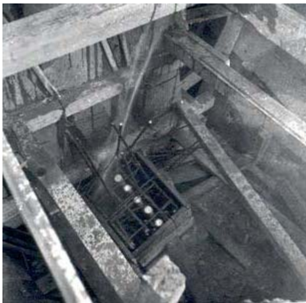
FIGURA 2.100 – Fotografia tirada antes da concretagem do pilar externo, em que são mostrados os pinos de ligação entre a fundação e o pilar
