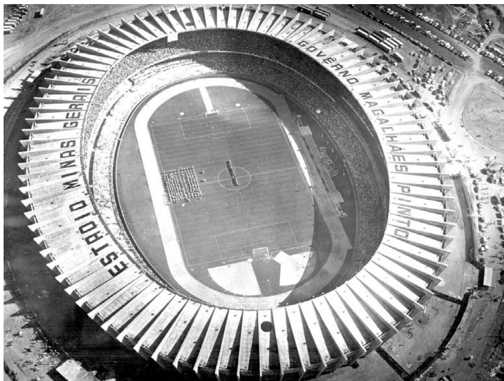
FIGURA 2.89 - Vista aérea do Estádio Minas Gerais no dia da sua inauguração
