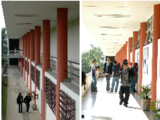
(3) Corredores do 1º e 2º andar do Prédio Escolar
