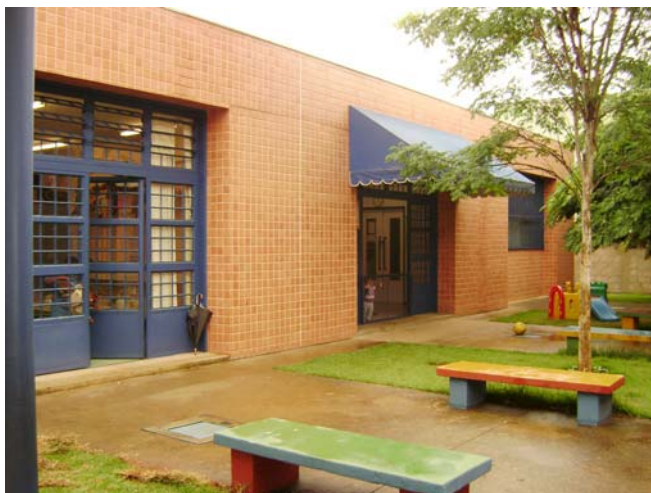
Figura 3: Vista do 2º bloco da escola pesquisada. RME/BH – 2008 Fonte: Foto da autora
