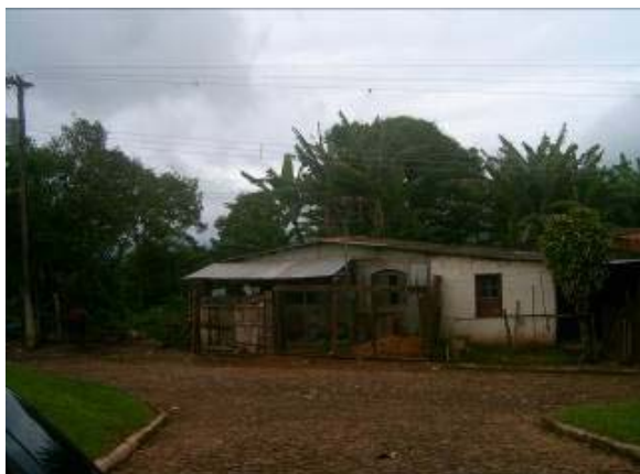
Figura 6 - Fachada de imóvel em Penedia
