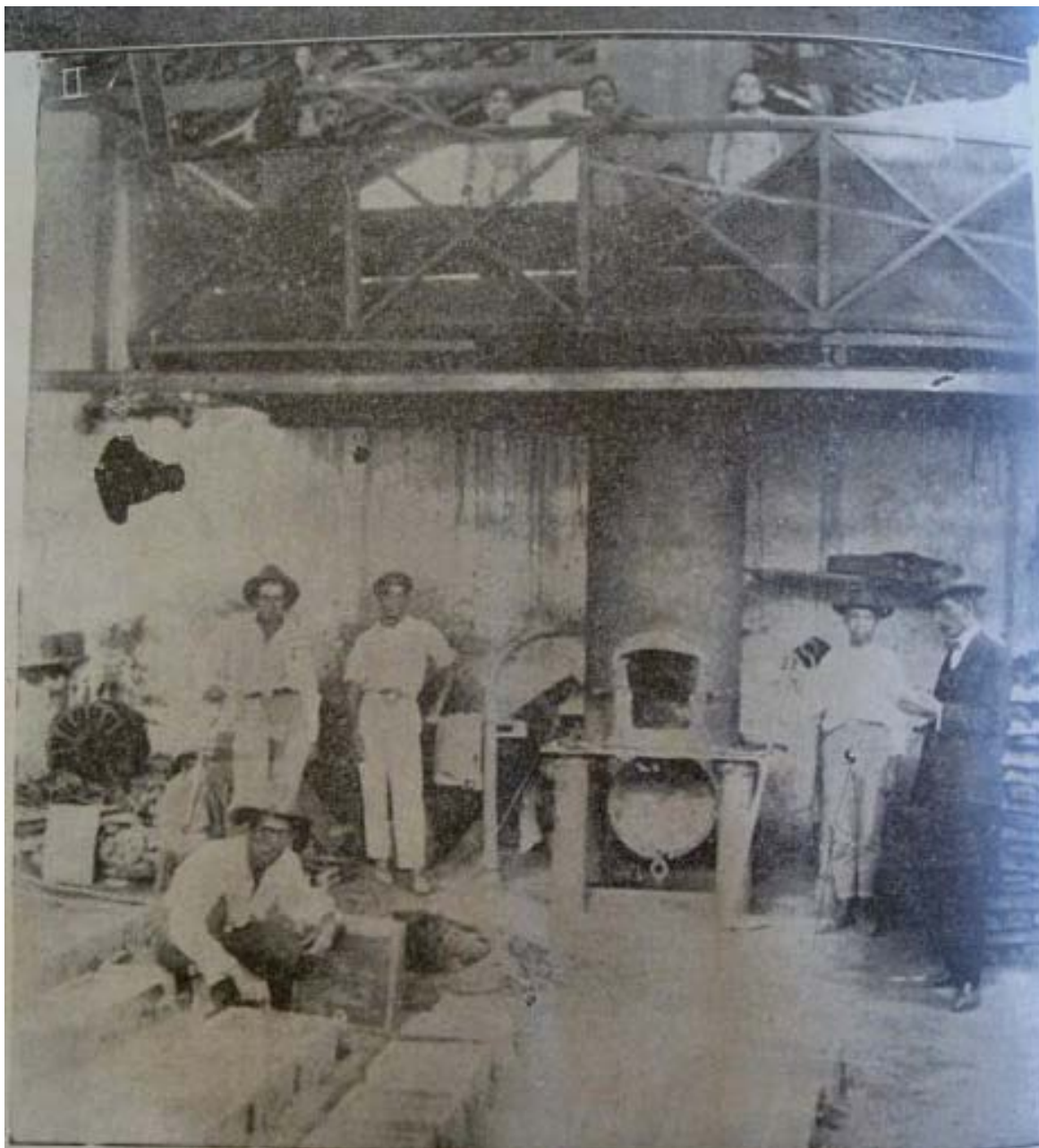
FIGURA 8: Fábrica de Tecidos do Marzagão: sala de fundição Fonte: SILVEIRA (1926, p. 1360)
