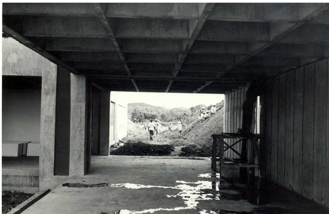
FIGURAS 25, 26 e 27 – Imagens da construção da nova sede da Escola de Educação Física, no Campus da UFMG
