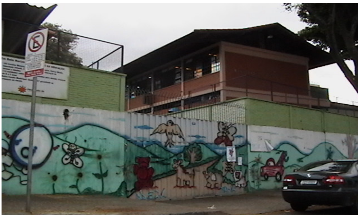
FIGURA 16: Fachada da Escola Municipal Monsenhor Artur de Oliveira.
