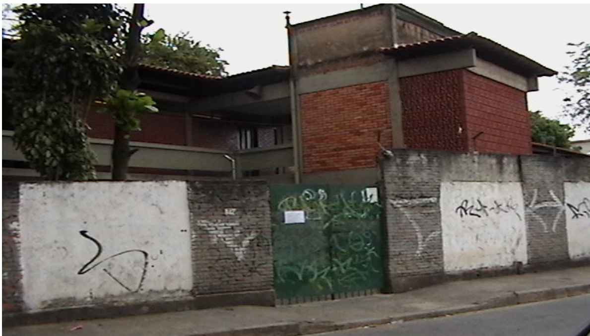
FIGURA 25: Fachada da E. E. Caio Nelson de Sena. Fonte: Foto de Libéria Rodrigues Neves
