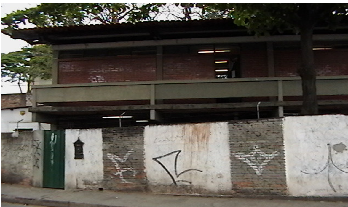
FIGURA 23: Fachada da E. E. Caio Nelson de Sena Fonte: Foto de Libéria Rodrigues Neves
