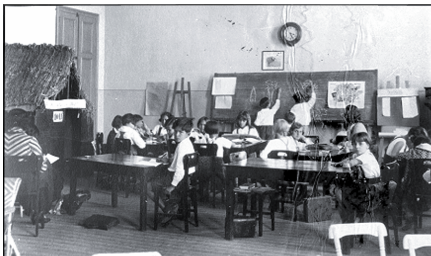
Figura 12 - Classe Anexa da Escola de Aperfeiçoamento. 1929
