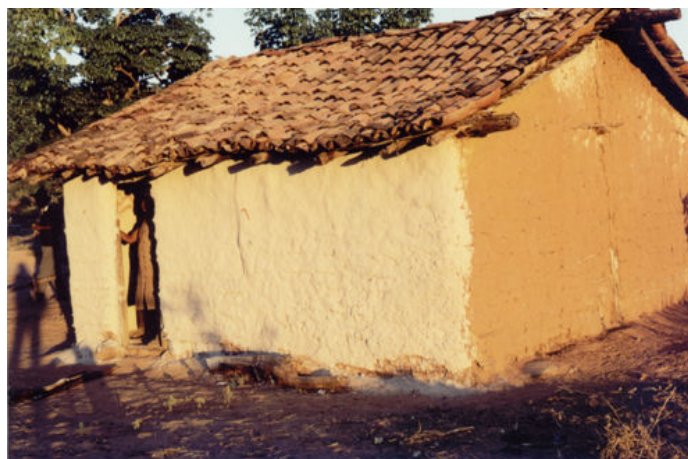
Foto : casa de D. Clementina pronta para receber as pinturas
