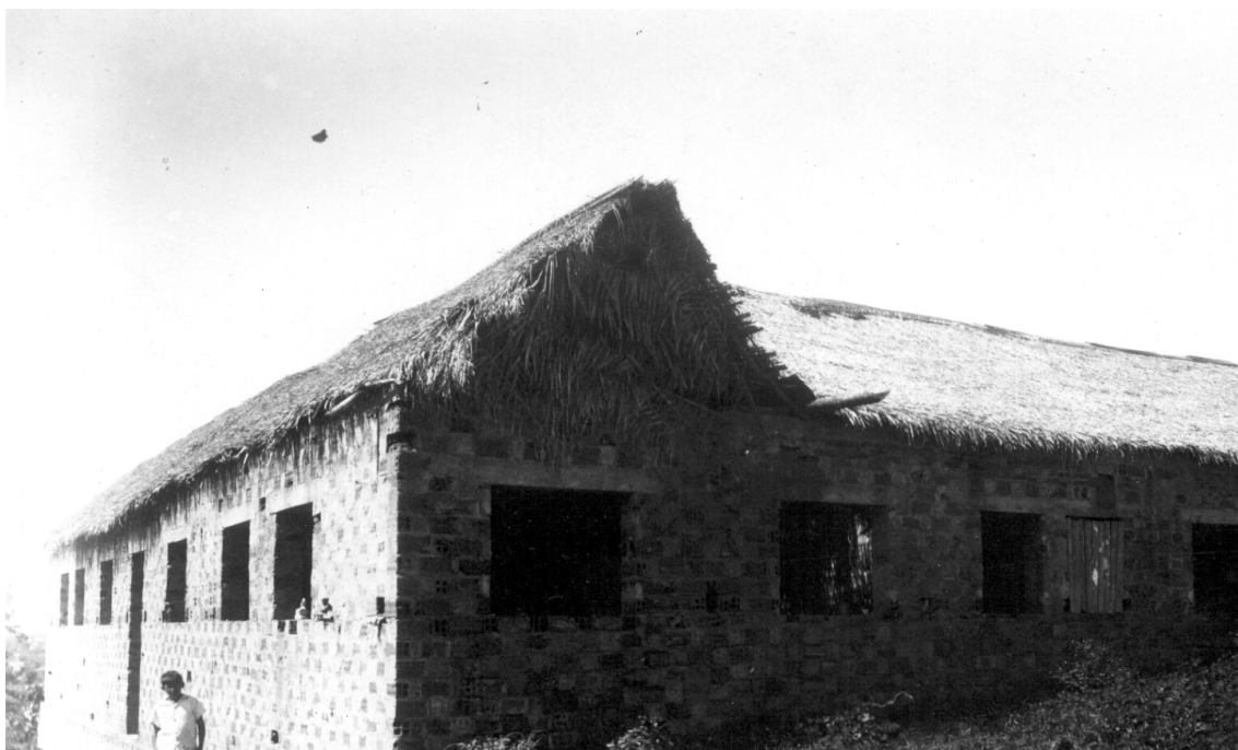
Figura 6: Construção escolar em alvenaria, coberta de palha. Fonte: Acervo particular de Maria Angélica de Castro, doado ao Centro de Cultura de Santo Antônio do Monte, Minas Gerais.
