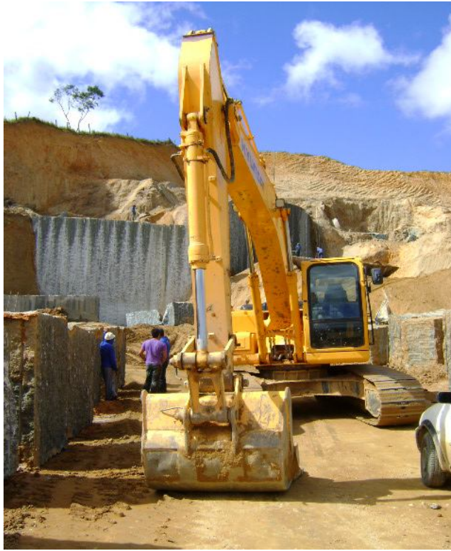
Figura 104 Retro-escavadeira utilizada na pedreira.
