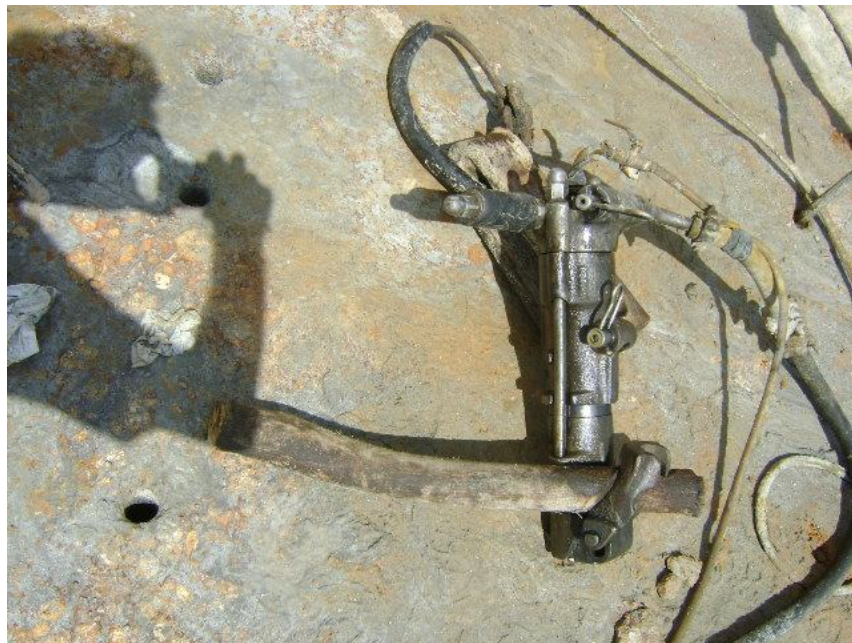
Figura 125 Martelo pneumático desligado aguardando o encaixe da broca e o conibite 84 para ser operado na perfuração de rochas. 85
