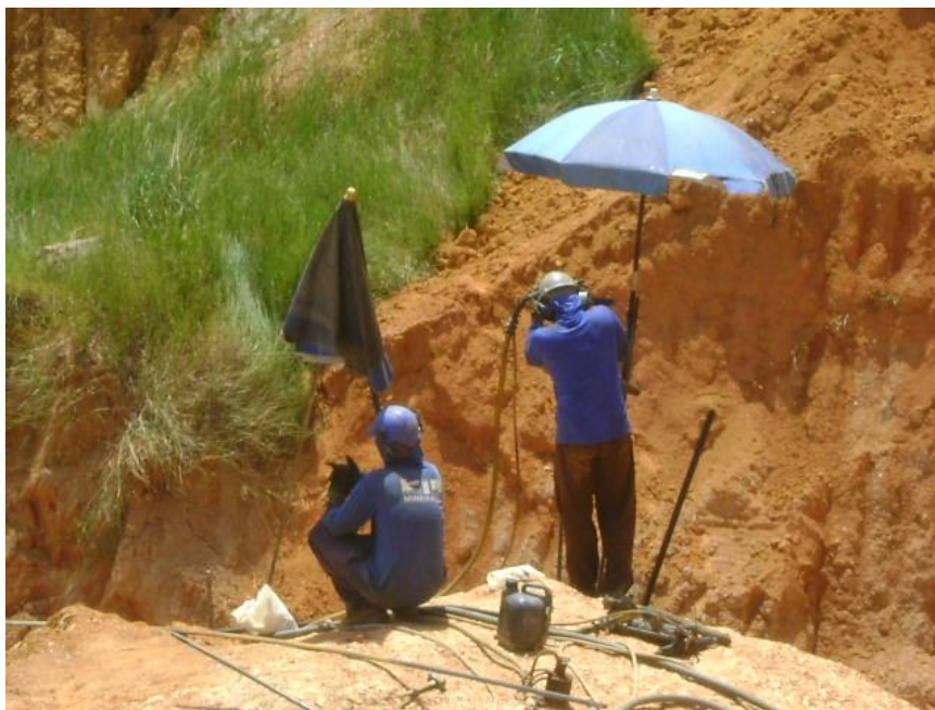
Figura 131 Perfuração sendo realizada com a utilização da sombrinha;
