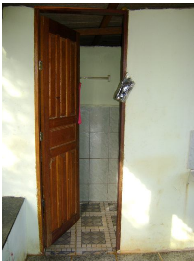
Figura 82 Porta de entrada para o vestiário/banheiro, (julho de 2010);
