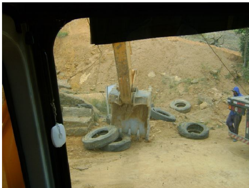
Figura 36 Colocação dos pneus na posição adequada para manter o bloco suspenso durante a instalação dos cabos;
