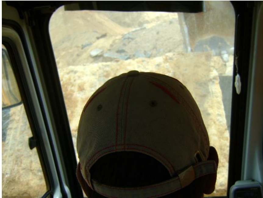
Figura 71 A fotografia registra a imagem vista pelo trabalhador no processo de movimentação de bloco.
