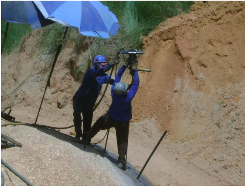
Figura 128 Na figura se visualiza a montagem do martelo pneumático. Interessante ressaltar que o martelo pneumático pesa em torno de 37 Kg e as brocas varia, chegando a pesar 80 kg.
