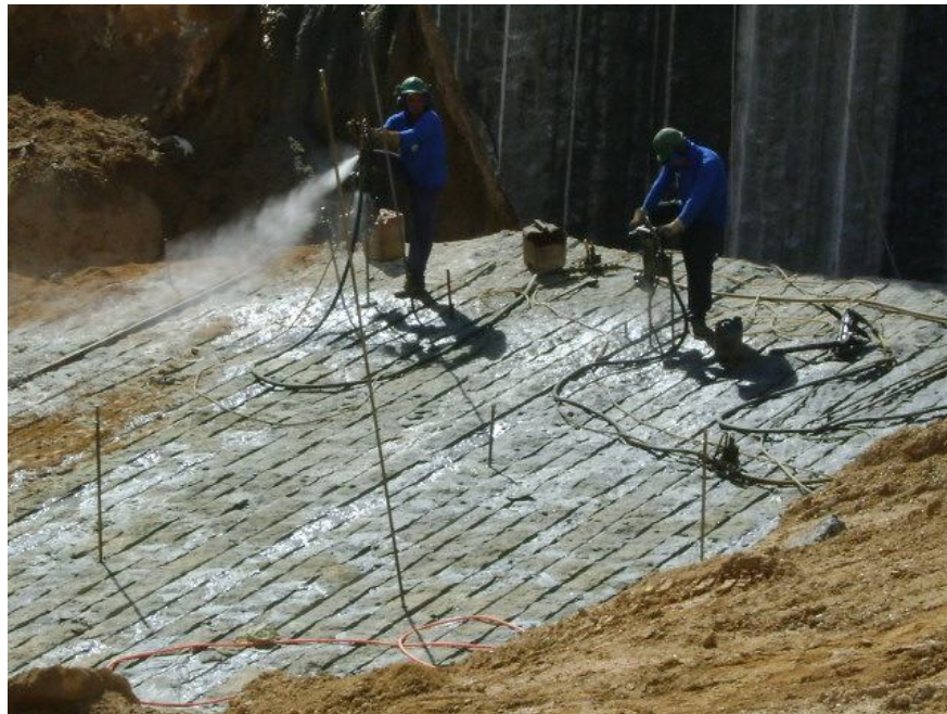
Figura 119 Martelo Pneumático com umidificação.
