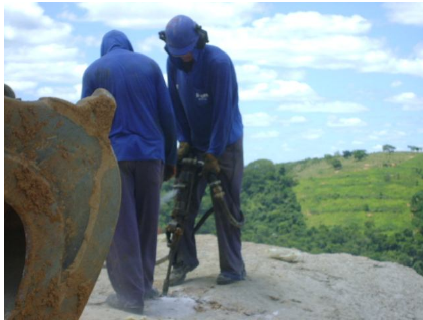
Figura 12 Finalização do trabalho manual na separação da prancha com o martetele pneumático. A separação se dá com a retro-escavadeira que empurra a prancha solta (Foto Janeiro de 2011).
