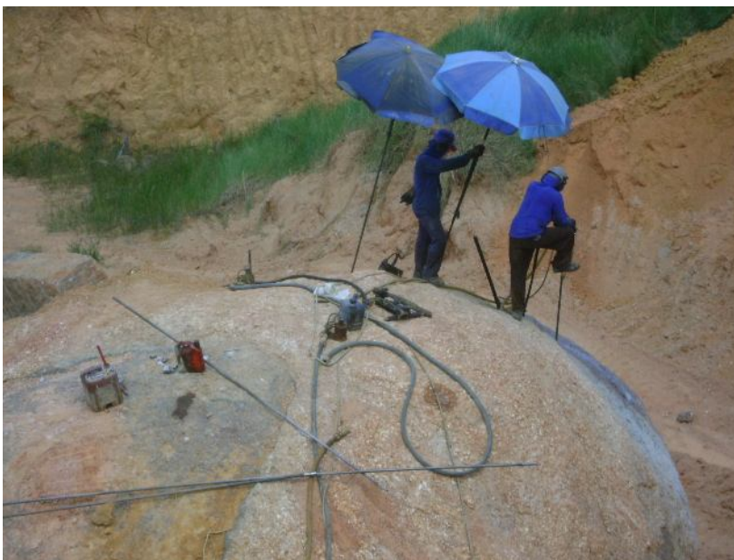
Figura 129 Processo de perfuração em andamento. Infelizmente, o recurso da fotografia não é capaz de possibilitar o leitor visualizar, os níveis de trepidação em que o trabalhador que exerce esta função, esta exposto.
