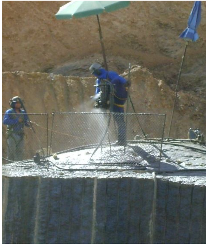
Figura 105 Marteleiteiro utilizando capacete, cinto de segurança, guarda sol, luvas, protetor auricular, bota, martelo pneumático umidificado e cerca de proteção para a realização de trabalhos em lugares altos.
