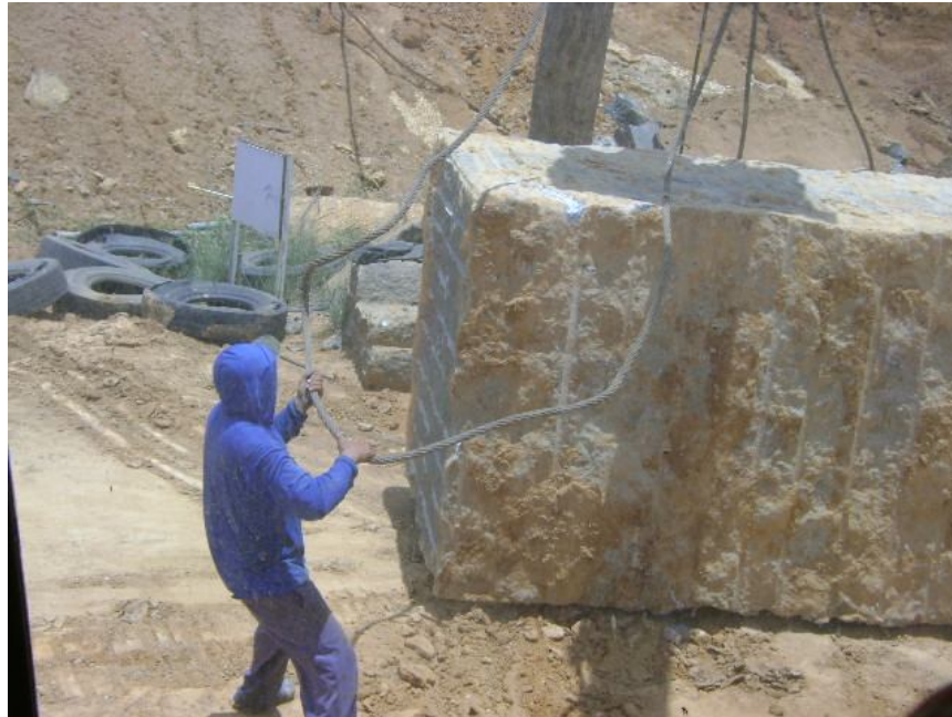
Figura 39 Ajustamento dos cabos para a colocação dos mesmos visando à suspensão do bloco;
