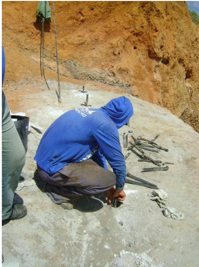
Figura 9 Trabalhador inserindo cunhas a serem batidas nos locais com necessidade em se completar a separação da prancha (Foto Janeiro de 2011);
