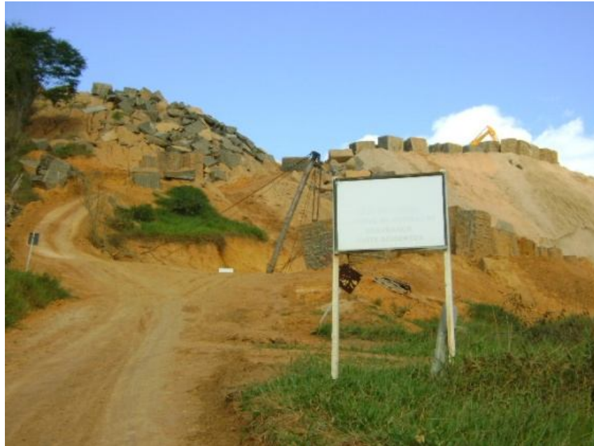
Figura 86 Placa na entrada da pedreira;
