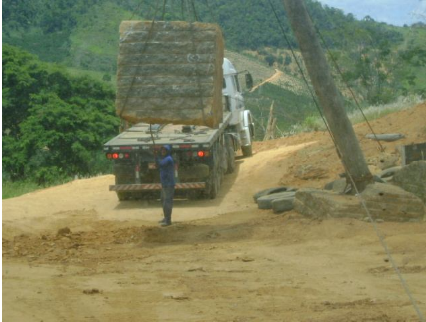
Figura 45 Trabalhador acertando a posição do bloco suspenso. Após posicionar o bloco suspenso, o operário prende o cabo no pau-de-carga para, assim, mantém o bloco parado;
