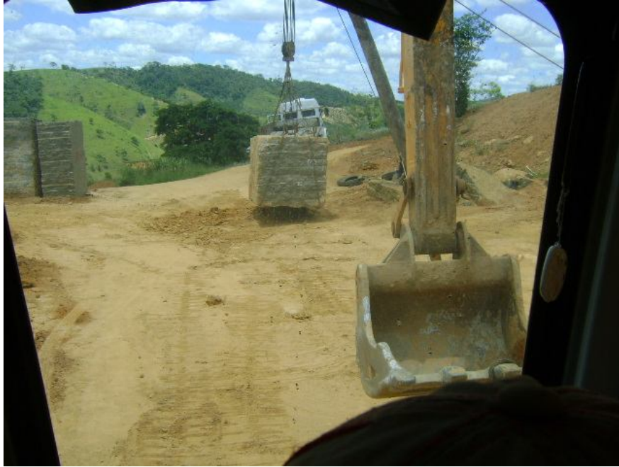
Figura 43 Bloco sendo suspenso pela retro-escavadeira que vai puxando o bloco com o cabo preso em seu garfo andando de marcha ré;
