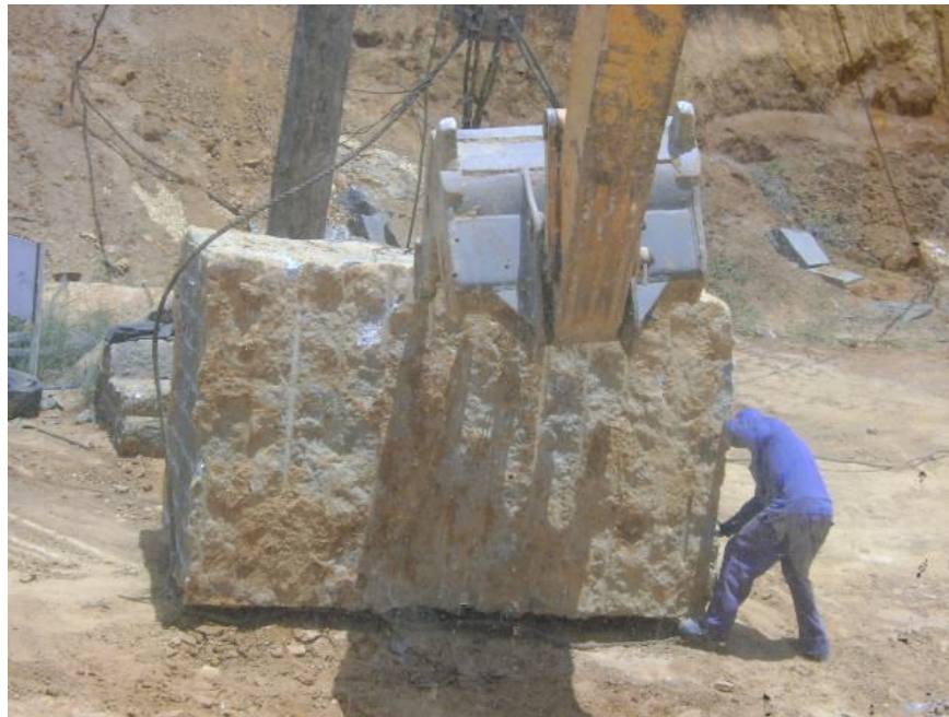
Figura 40 Colocação do cabo no bloco. A máquina ajuda o trabalhador levantando o bloco para que este possa passar o cabo;
