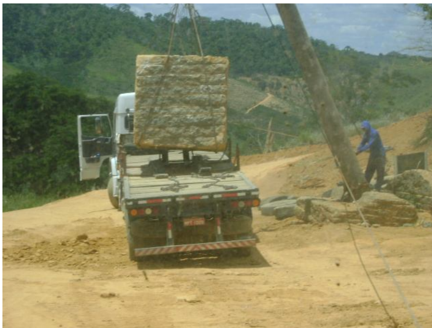
Figura 47 O trabalhador solta o cabo que utiliza no controle do bloco suspenso e o operador de máquinas desce o bloco sobre a carroceria da carreta;
