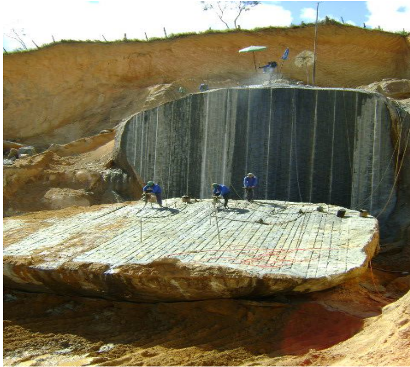
Figura 7 Marteteiros na parte superior fazendo furos para derrubamento de prancha; na parte inferior, marteteiro preparando a prancha para a retirada de blocos.
