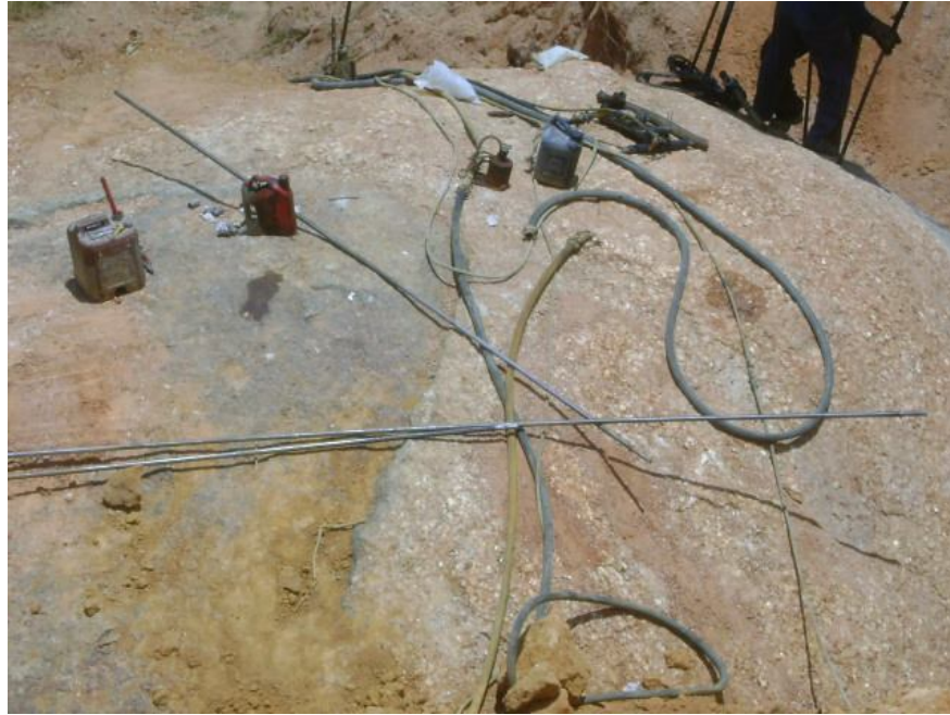
Figura 133 A foto mostra o galão de água (azul) para consumo dos trabalhadores. Não é fornecido no local de trabalho copo para a ingestão de água.
