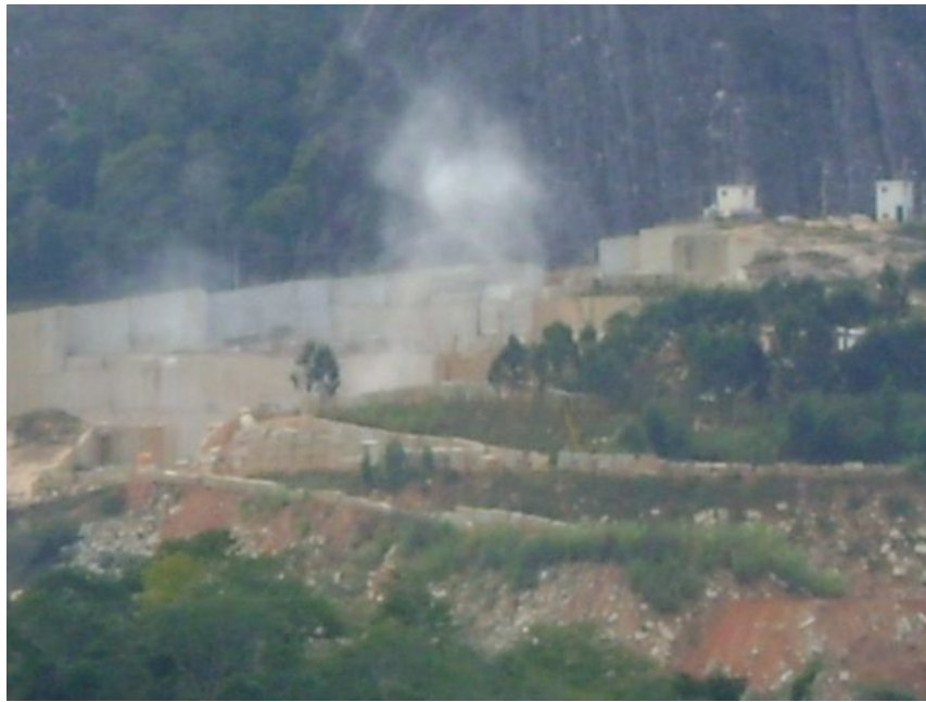
Figura 118 Poeira provocada pelo fogo (explosão), registrada ao longe, de uma pedreira.
