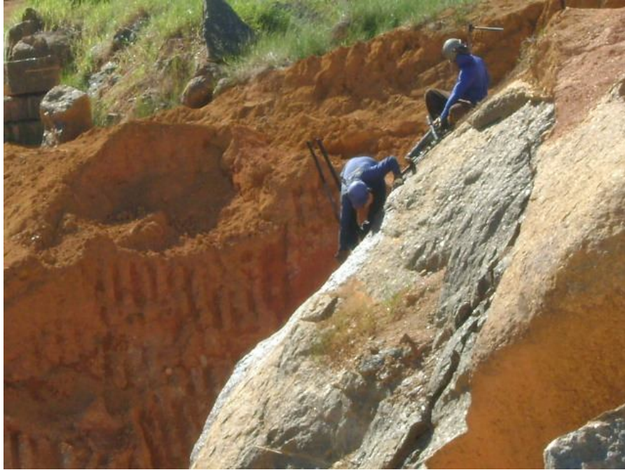
Figura 6 Trabalhador retirando aço em mina perfurada. Ele se apóia em outro aço enquanto encaixa cuidadosamente o aço que será engatado ao martelo pneumático. É possível observar o trabalhador mais acima segurando o martelo pneumático para o operador que executará a função.
