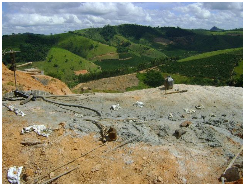
Figura 121 Praça de perfuração de rochas umidificada pela água saída dos martelos pneumáticos. Notamos os efeitos do sol e calor no processo e secagem do pó de sílica.
