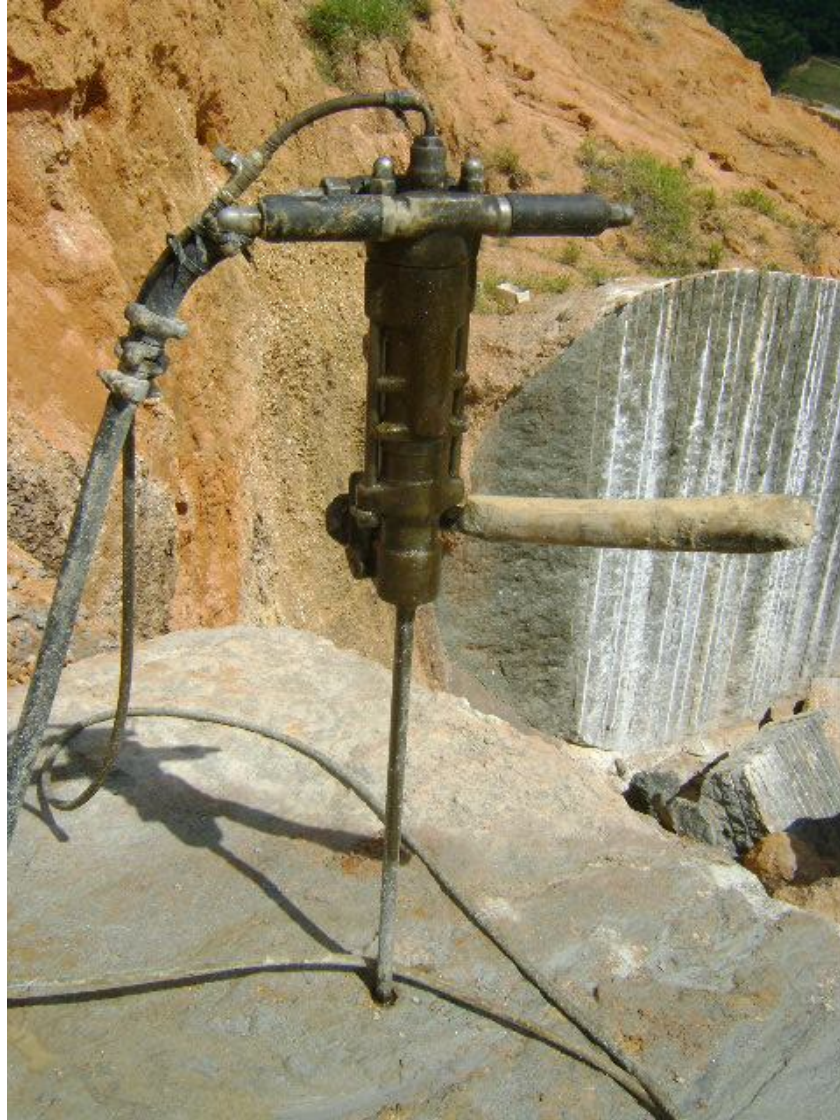
Figura 64 Martelo pneumático montado e pronto para ser operado.
