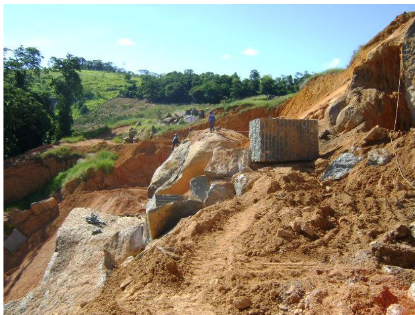
Figura 101 Visão completa do local, para que se tenha ideia da altura da rocha. (Foto tirada em janeiro de 2011)
