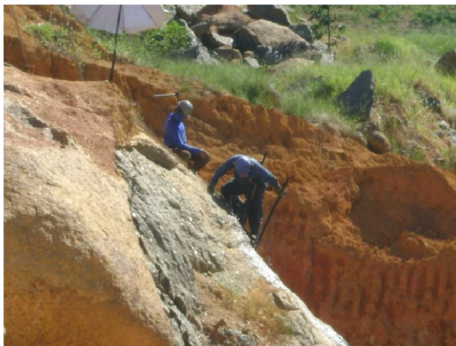
Figura 5 Após furar mina, trabalhador se apóia em aços dentro de outras minas, na retirada da broca da mina furada.
