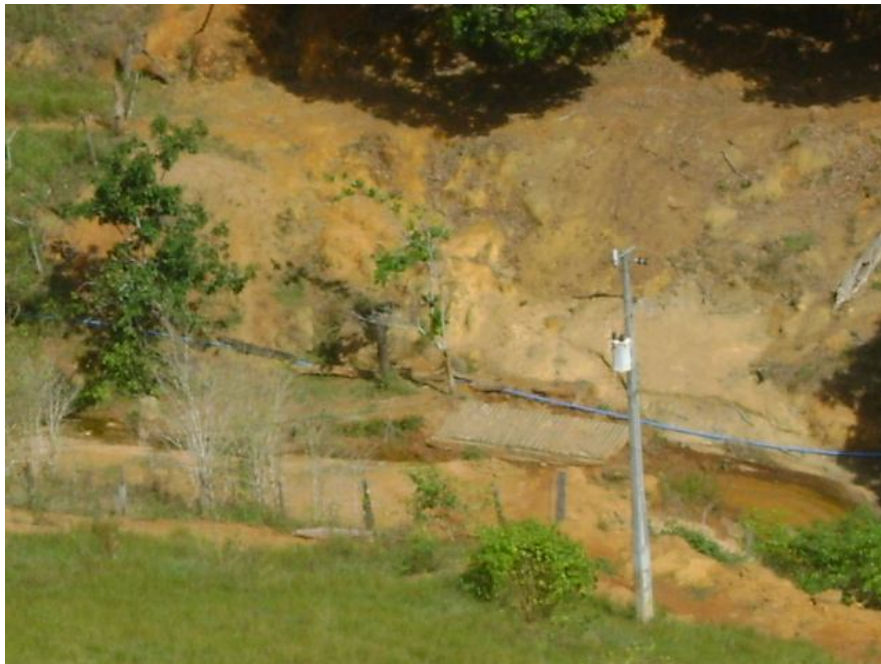
Figura 72 Riacho de onde é obtida a água, cano passando em sua margem, julho de 2010;
