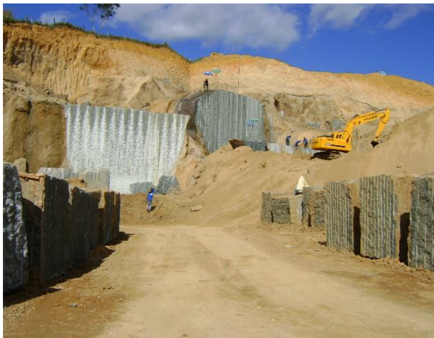
Figura 28 retro-escavadeira em operação.
