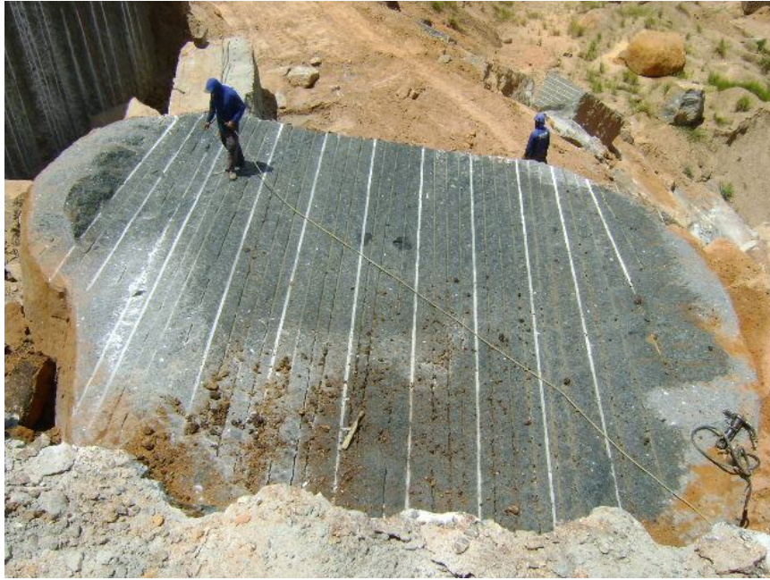
Figura 16 Limpeza/lavagem da prancha após tombamento;
