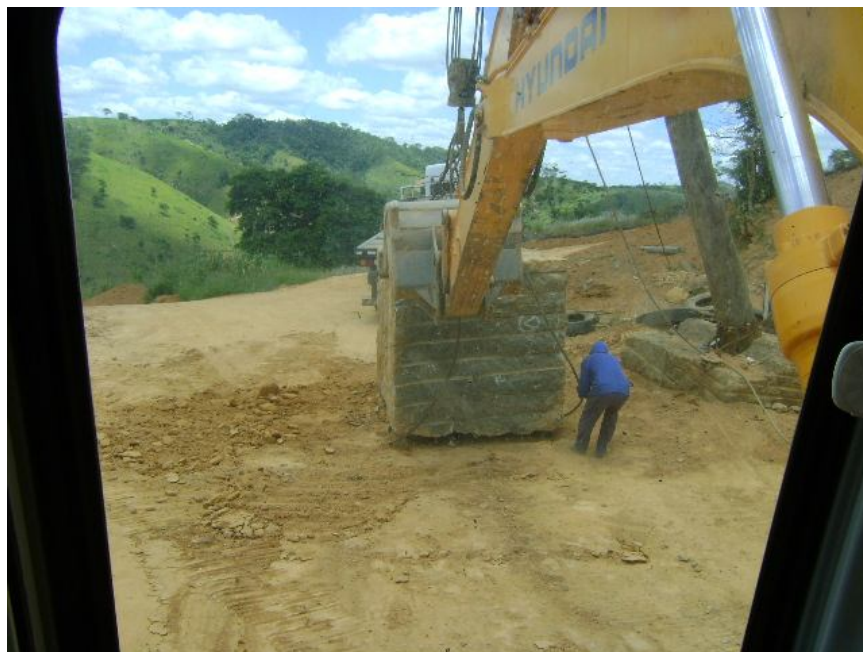
Figura 41 Finalização do entrelaçamento para suspensão do bloco;
