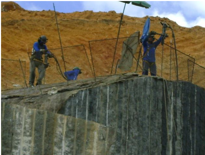
Figura 65 Marteleiro realizando o trabalho de furação das minas 40 .
