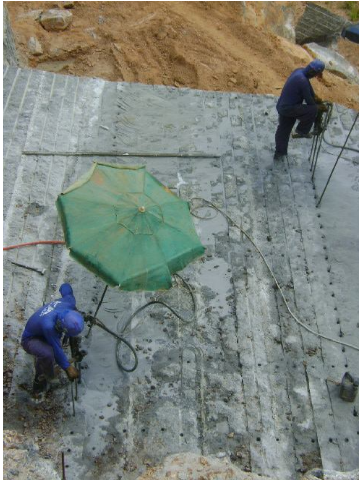
Figura 17 Marteleiro furando a prancha para a retirada dos bloco;
