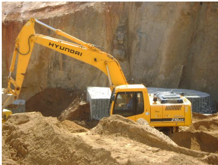
Figura 66 Máquina realizando limpeza dos locais de trabalho 41 .
