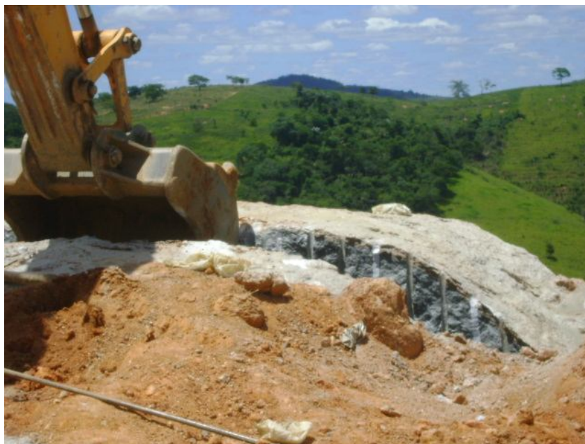
Figura 13 Tombamento da prancha pelo retro-escavadeira 27 ;
