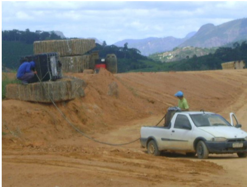
Figura 112 Processo de armazenamento de combustível para abastecer os compressores geradores de energia da pedreira.
