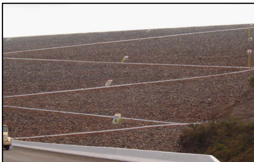
Foto 5 – A Barragem de Irapé de 208 metros de altura. Julho 2006.
