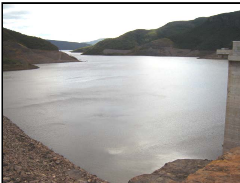
Foto 3 – Lagoa do reservatório em processo de enchimento. Julho 2006.
