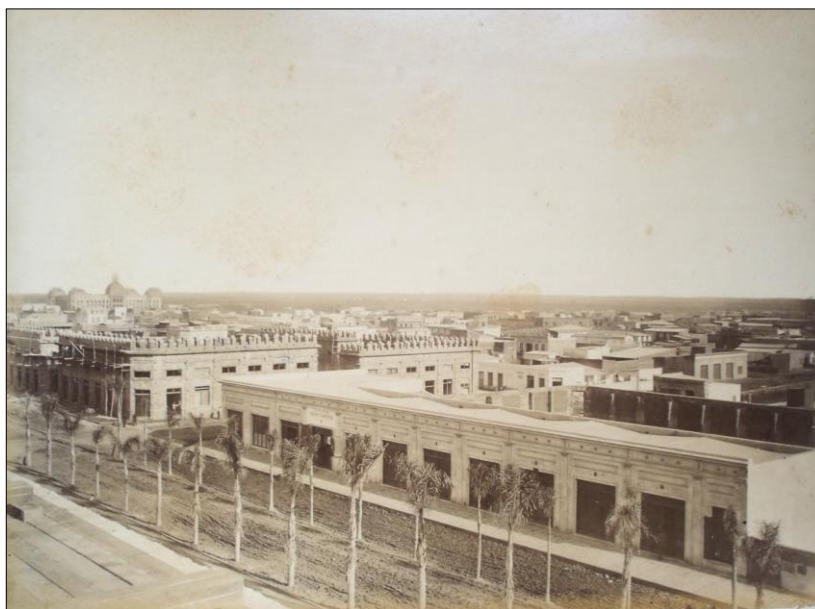
FIGURA 16 – Panorama de una parte de la ciudad mirada del este Fonte: Vistas de La Plata desde su fundación. Noviembre de 1882 a junio de 1884.
