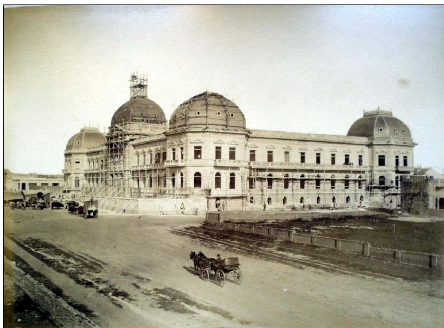
FIGURA 18 – Palacio de Justicia (en construcción)
