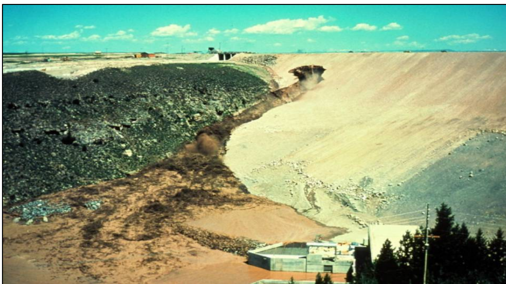
Figura 3.4 – Formação de piping na barragem Teton - Rexburg, Idaho – EUA Fonte: Disponível em http://www.geol.ucsb.edu/faculty/sylvester/Teton%20Dam/Teton%20Dam-Pages/Image0.html . Acesso em: 24 de abril de 2007.
