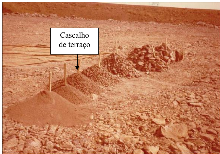
Figura 5.18 – Materiais de granulometria diferenciada, aplicados na construção do maciço (rocha em basalto, cascalho de terraço e areia argilosa)
