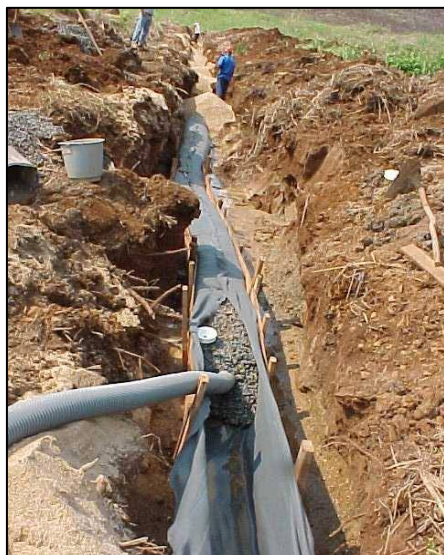
Figura 5.28 – Detalhe da obra de tratamento de surgências com canaletas de drenagem Fonte: Modificado de CEMIG, 2003, p.4.
