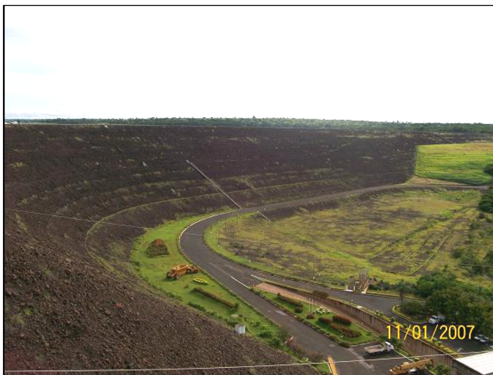
Figura 5.15 – Vista parcial da transição nº 2 e barragem de enrocamento
