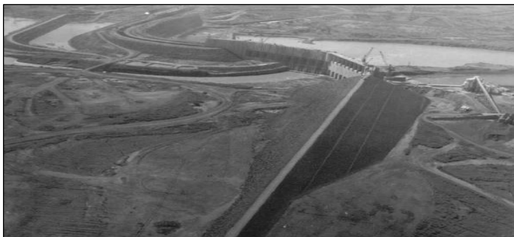
Figura 5.6 - Vista da barragem de terra da margem direita (época da construção)
