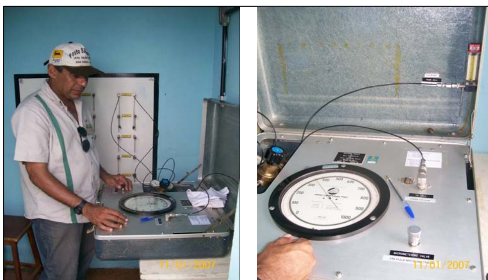
Figuras 5.38 - Leitura de piezômetros hidráulicos PH's (margem esquerda)
