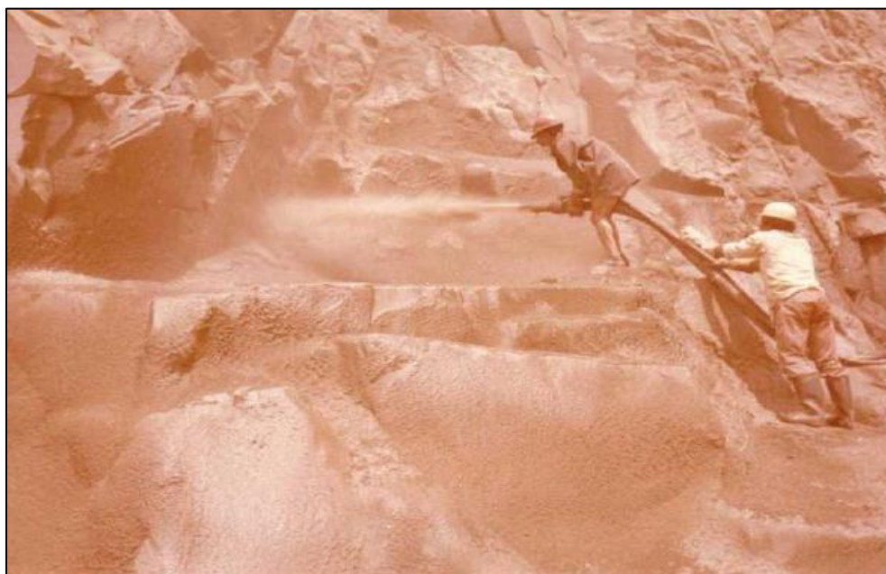
Figura 5.19 – Preparação da rocha de fundação no leito do rio com jatos de água e ar Fonte: CEMIG – GA/SM.
