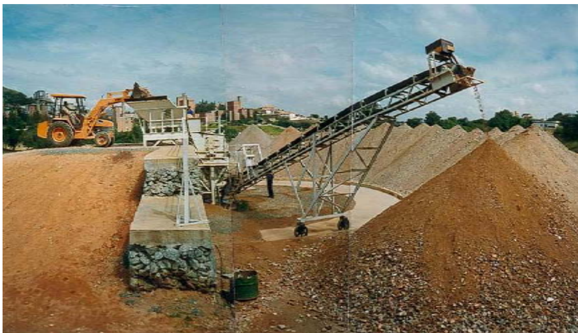
Figura 6 – Estação de reciclagem do Bairro Estoril Fonte: PINTO (2005 b)
