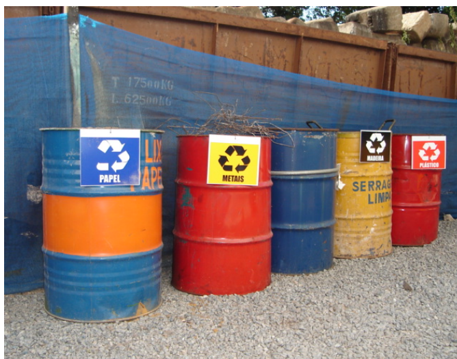
Figura 13 – Segregação de resíduos da obra industrial
