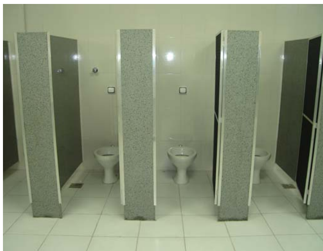
Figura 21 – Obra de reforma (sanitários)
