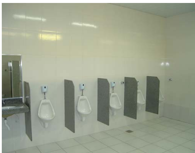
Figura 22 – Obra de reforma (mictórios)
