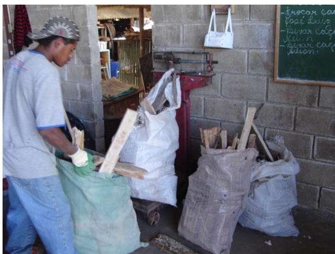
Figura 16 – Medição de resíduos de madeira da obra comercial
