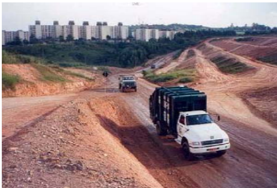
Figura 7 – Utilização do agregado reciclado na preparação de vias internas do Aterro Municipal. Fonte: PINTO (2005 b).
