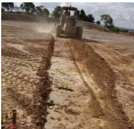
Figura 4.17 – Abertura de valas para implantação do sistema de drenagem de líquidos
