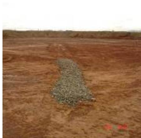
Figura 4.20 – Vista geral do material drenante na vala
