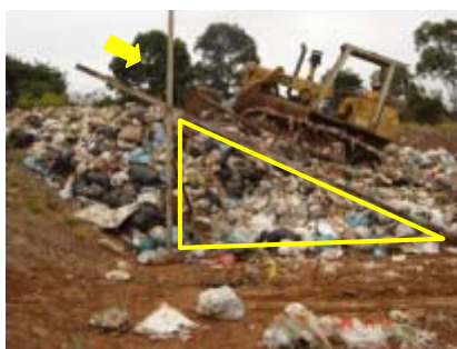
Figura 4.43 – Gabarito utilizado no controle da inclinação da rampa de compactação
