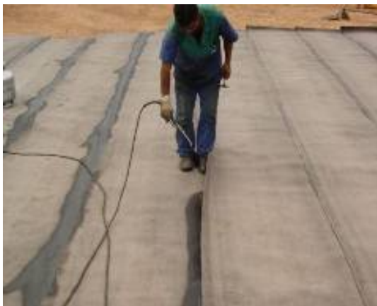
Figura 4.14 – Execução do sistema de revestimento de fundo – Instalação da manta, 2005
