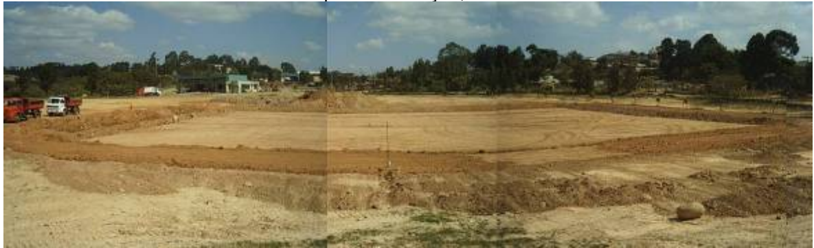
Figura 4.11 – Construção dos diques de contenção, 2004
