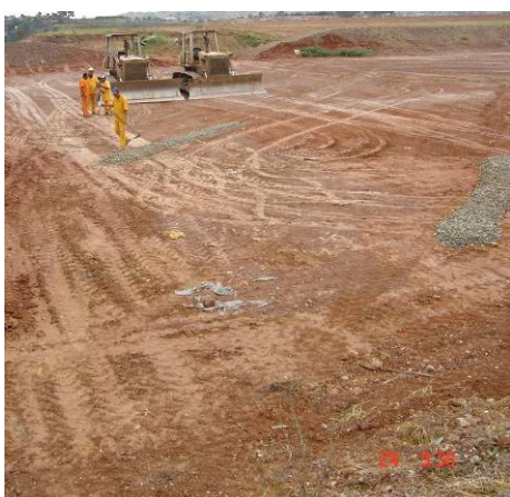
Figura 4.21 – Conformação manual do material drenante
