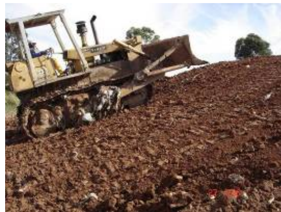
Figura 4.39 – Execução da camada de cobertura final - solo
