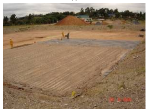
Figura 4.15 – Execução do sistema de revestimento de fundo – Instalação da camada de proteção mecânica, 2005
