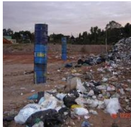
Figura 4.25 – Fôrmas metálicas instaladas
