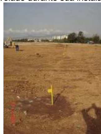
Figura 4.49 – medidor de recalques instalado
