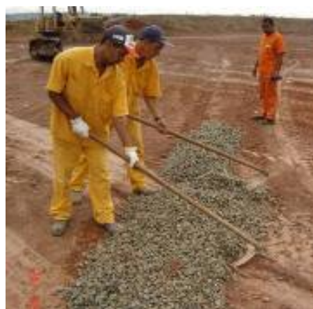
Figura 4.22 – Conformação manual do material drenante
