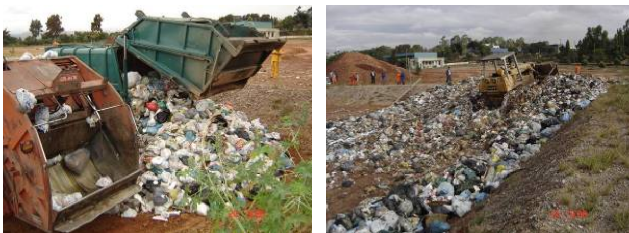
Figura 4.35 – Descarga e Compactação de RSU
