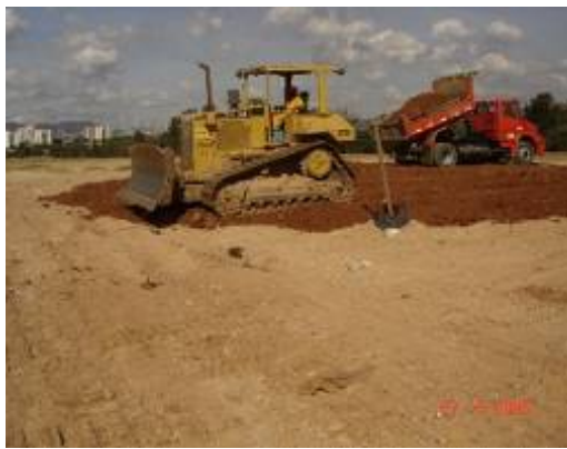
Figura 4.38 – Execução da camada de cobertura final – entulho + solo
