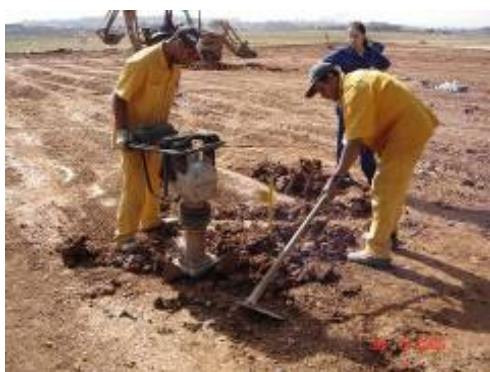
Figura 4.48 – Medidor de recalques sendo instalado
