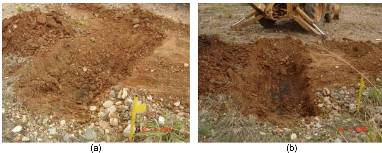
Figura 5.20 - Início do processo de escavação
