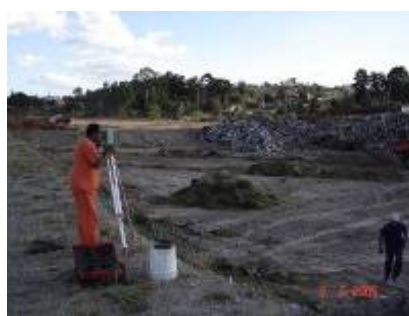
Figura 4.45 – Leitura da inclinação da rampa de aterragem
