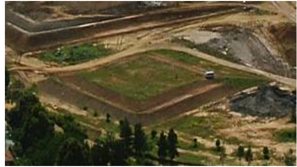
Figura 4.6 – Vista aérea do Aterro Sanitário Experimental, 2006
