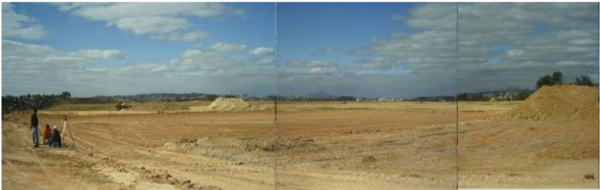
Figura 4.10 – Terraplanagem visando a regularização da base para instalação da impermeabilização, 2004
