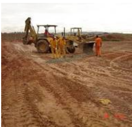
Figura 4.19 – Lançamento de material drenante
