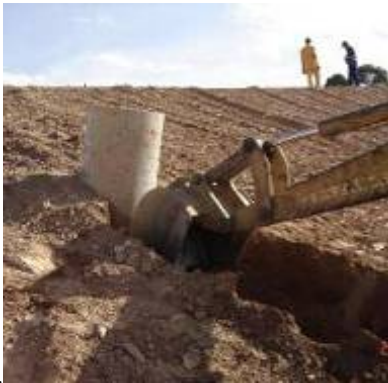
Figura 4.29 – Escavação para instalação da tubulação de PVC
