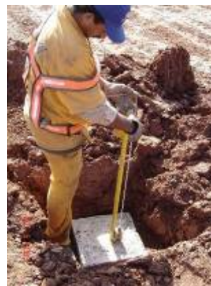
Figura 4.47 – Medidor de recalques sendo nivelado durante sua instalação
