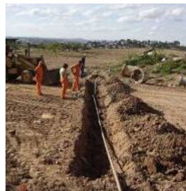
Figura 4.30 – Vala com tubulação de PVC
