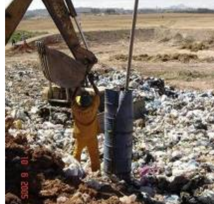
Figura 4.27 – Fôrma metálica içada
