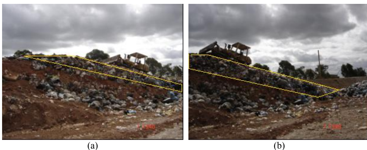
Figura 5.12 – Vista das espessuras final das camadas de RSU durante a aterragem
