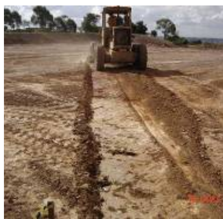
Figura 4.18 – Abertura de valas para implantação do sistema de drenagem de líquidos
