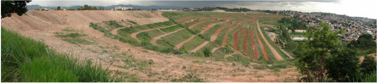
Figura 4.2 – Visão geral dos taludes AC-03, AC-04 e AC-05 (em primeiro plano)
