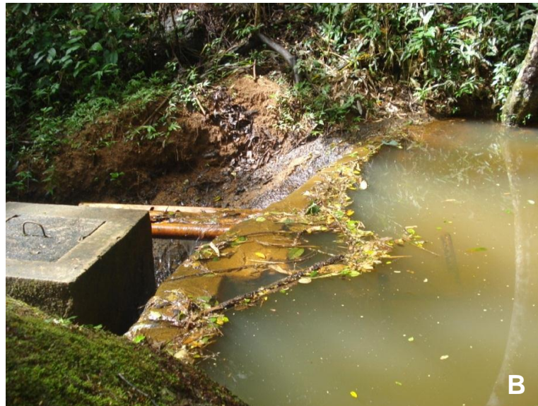
FIGURAS 9A e 9B - Fotos da “barragem” do córrego Maranhão dentro da mata. Na foto B, detalhe do “filtro” citado anteriormente pelo funcionário da Prefeitura, Salvador
