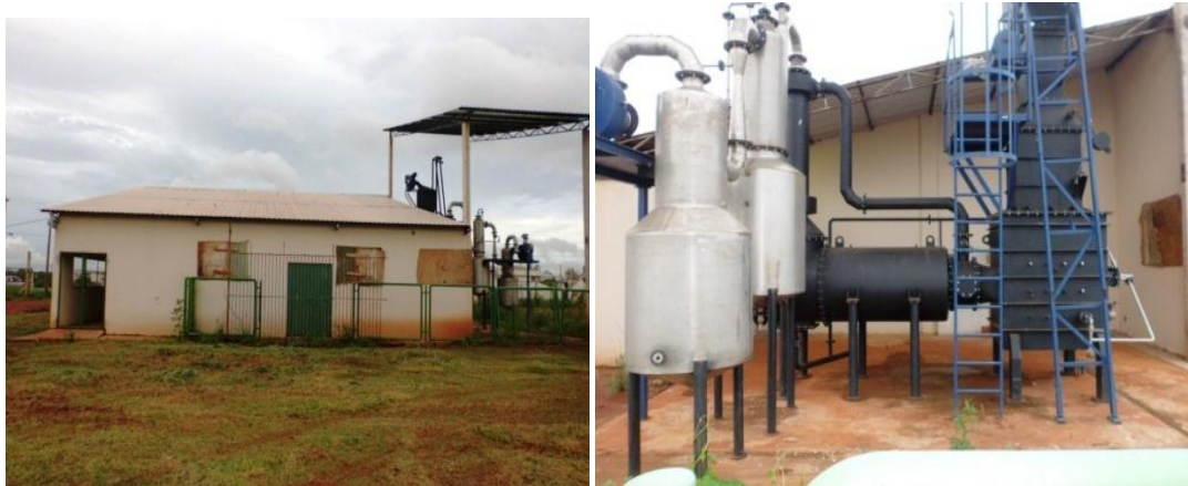
Figura 33: Abrigo externo e usina de tratamento de RSS em construção, HPR, 2011. Fonte: Fonte: Macedo, J. I.
