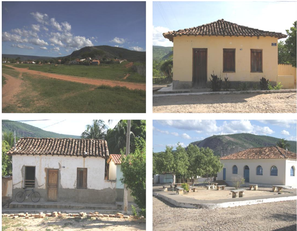
Figura 3 - Vila Central de São Pedro, distrito rural de Jequitinhonha, Minas Gerais
