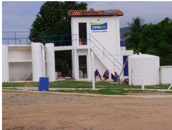
Figura 5 - Estação e tratamento de água, São Pedro do Jequitinhonha, Minas Gerais
