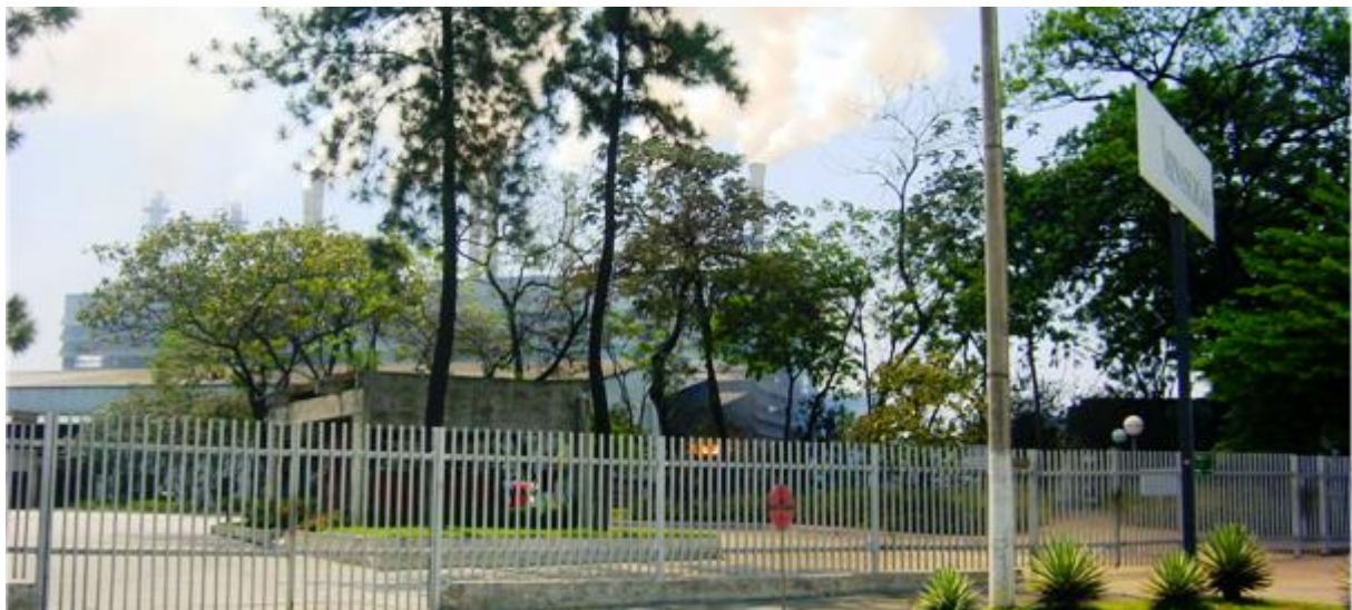
Ilustração 13. Fábrica metalúrgica Cia. Ferro Ligas de Minas Gerais – MINASLIGAS, Pirapora/MG. Foto: José Andrade
