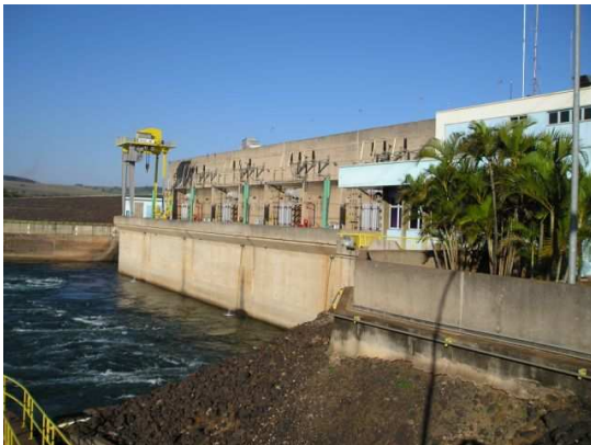
Figura 4.2 – Vista externa da casa de força
