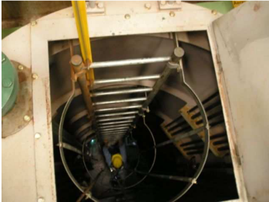
Figura 4.4 – Escada de acesso ao gerador
