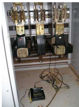
Figura 4.9 – Medição da tensão no terminal da chave, Caso A
