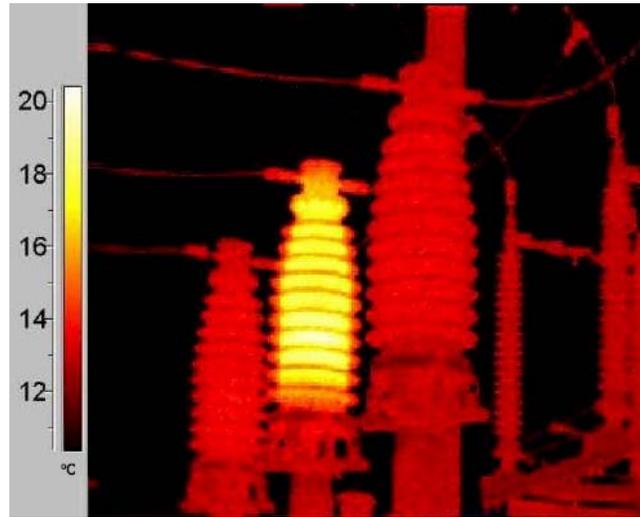
**Figura 2.5 - Termograma para um sistema de pára-raios
