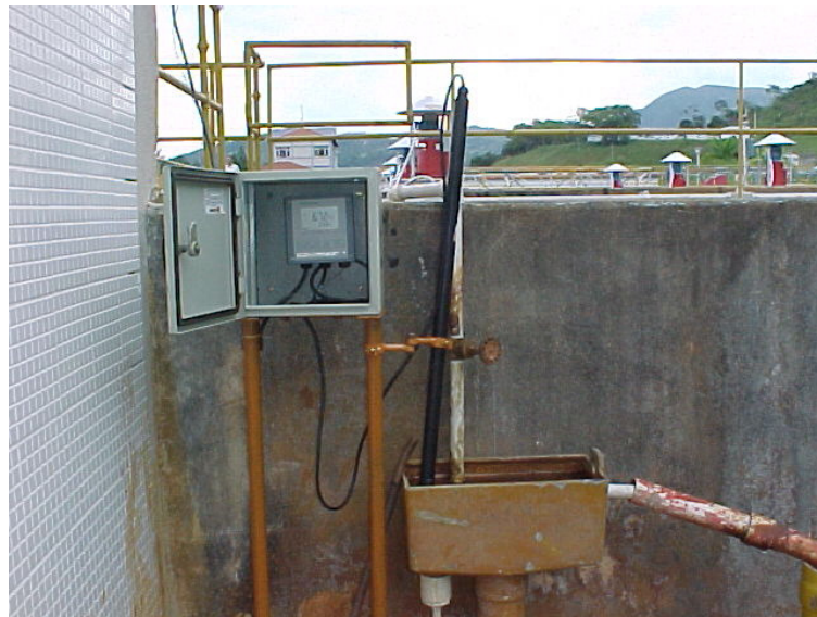
FIGURA 3.7: Analisadores de pH - Água Coagulada
