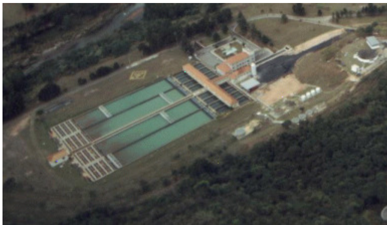
FIGURA 1.2: Foto aérea da Estação de Tratamento de Água do Rio das Velhas
