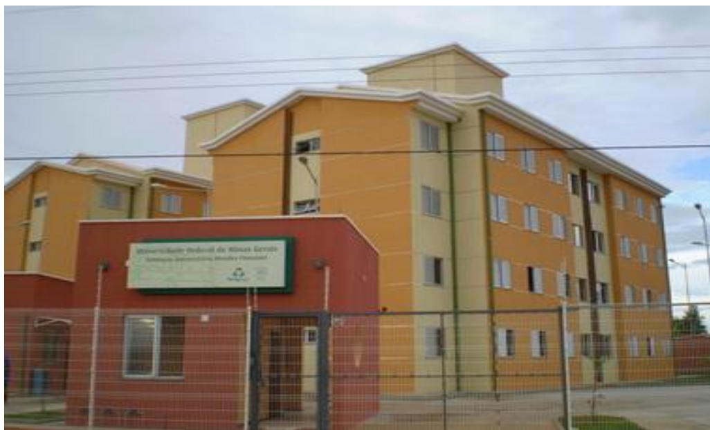
Figura 10 - Prédio da Moradia Universitária em Montes Claros
