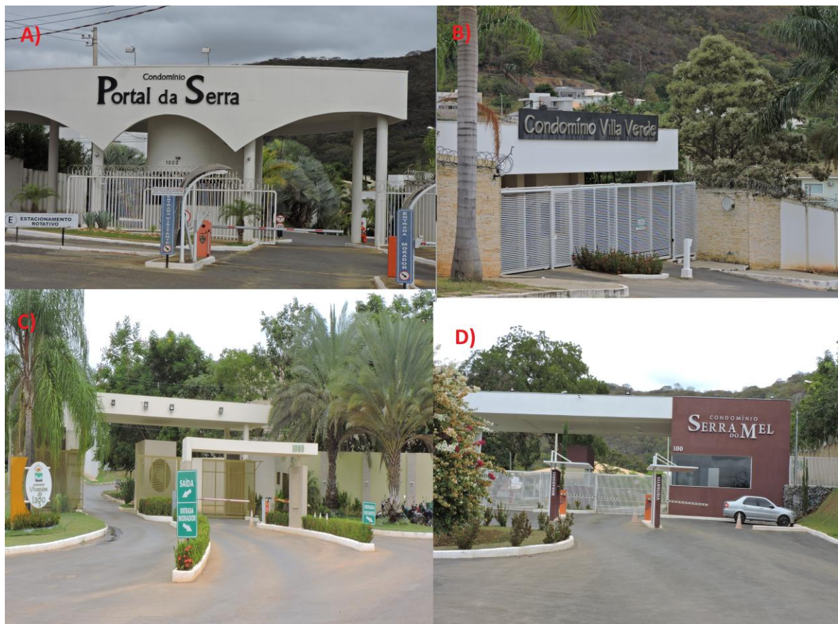
A) Imagem da fachada de entrada do condomínio Portal da Serra; B) Imagem da fachada de entrada do Condomínio Villa Verde. C) Imagem da fachada de entrada do Condomínio Vivendas dos Lago. D) Imagem da fachada de entrada do Condomínio Serra do Mel Fonte: Acervo pessoal. Org.: GALVÃO, L. G. M.
