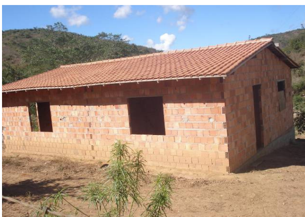
FIGURA 65: Casa em construção (Atorã – jul. de 2011). FOTO: RODRIGUES, 2011.
