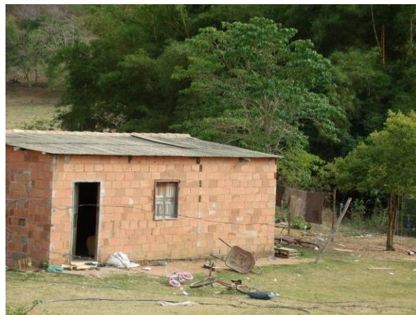
FIGURA 105: Casa às margens do córrego oriente (mata ciliar ao fundo).
