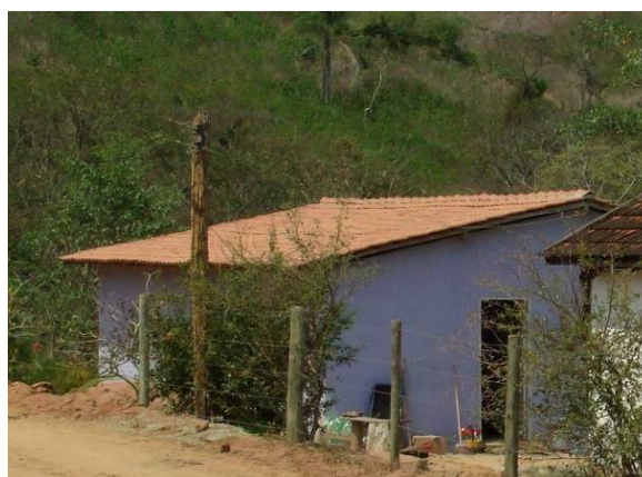
FIGURA 66: Casa pronta (Atorã – set. 2012). FOTO: RODRIGUES, 2012.
