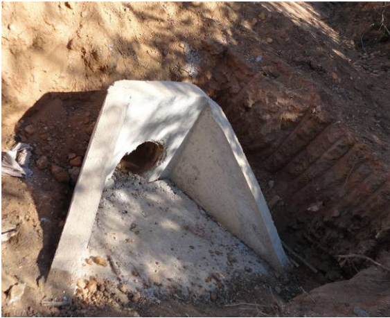
FIGURA 121: Instalação de novos desvios de água. FOTO: RODRIGUES, 2011.
