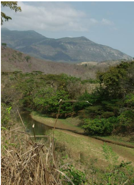
FIGURA 79: Assoreamento do rio Eme. FOTO: PETRONILHO, 2011.
