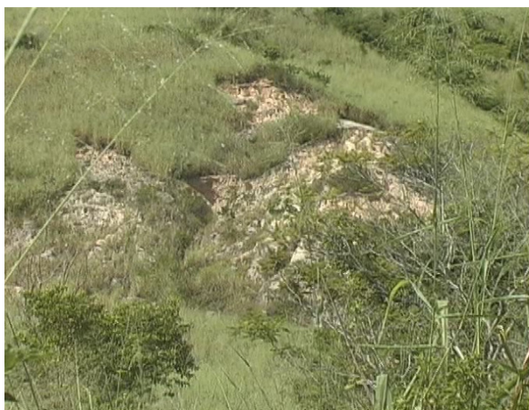
FIGURA 89: Voçoroca nas proximidades do Córrego Sempre Verde.
