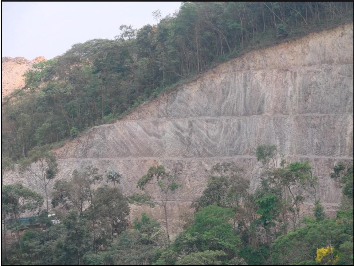
Foto 5 – Vista NNE do talude de estrada que expõe o típico padrão estrutural do lineamento Córrego do Sítio (S0 dobrado pelo dobramento F n ), a vergência é para NW. Cada bancada do talude tem aproximadamente 5 m.
