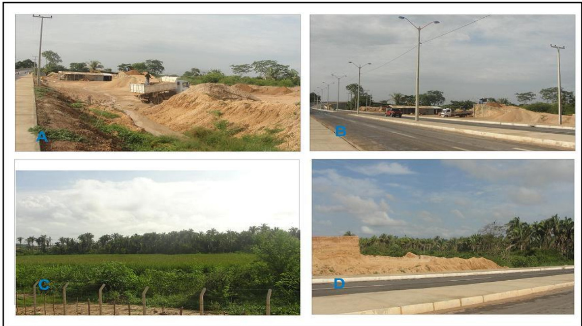
Figura 45 – Fotografias em mosaico mostrando danos ambientais nas proximidades dos bairros Mocambinho, Pedra Mole e Aroeiras, Zona Norte de Teresina-Piauí.
