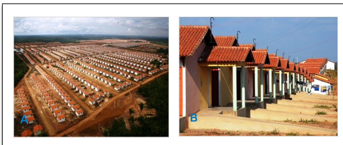
A: Vista panorâmica do Conjunto Jacinta Andrade. B: Detalhe da estrutura das casas do Conjunto.
