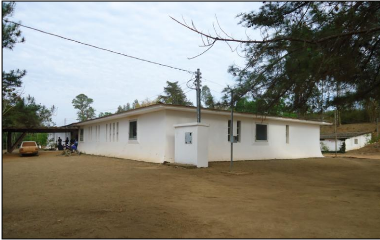
FIGURA 22: Hospital da Fazenda do Alagadiço construído em princípios da década de 1980 pela Fundação Pietro Salini. Fazenda do Alagadiço, Município de Minas Novas, Vale do Jequitinhonha/MG. AUTOR: DINIZ, R. F. 2012
