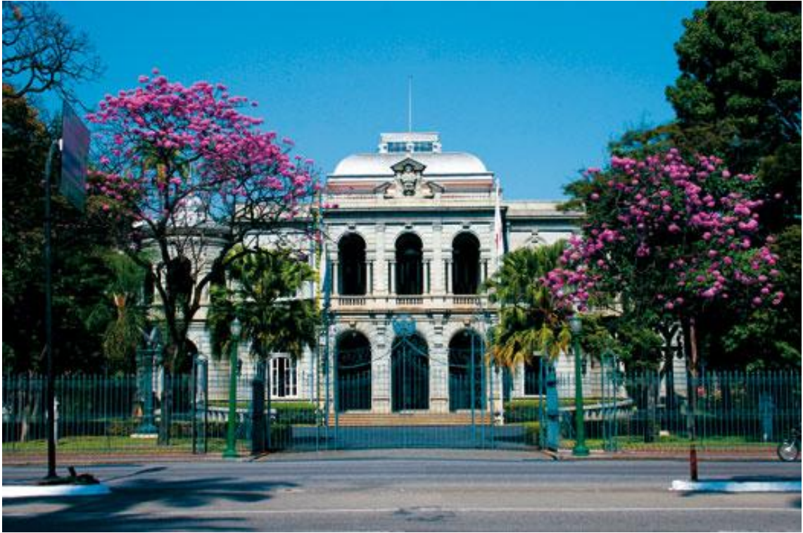
Imagem 17. Foto da fachada do Palácio da Liberdade em 2012. Autor: Pedro Resende.
