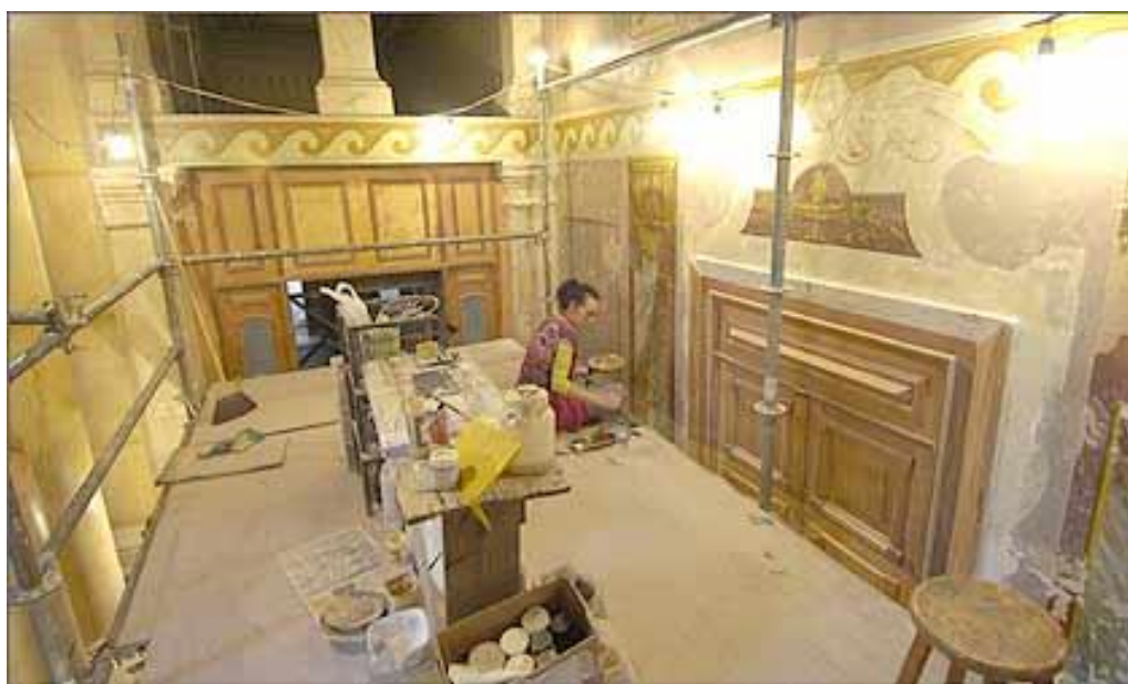
Imagem 16. Processo de restauração em edifício da Praça da Liberdade em 2009. Disponível em: < http://defender.org.br/tag/palacio-da-liberdade/ >. Acesso em 13 de agosto de 2013.
