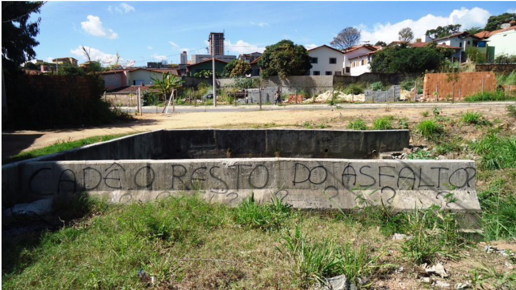
Figura 19: População reivindicando o asfaltamento na Rua dos Mouras, “não contemplada no escopo do projeto do DRENURBS”
