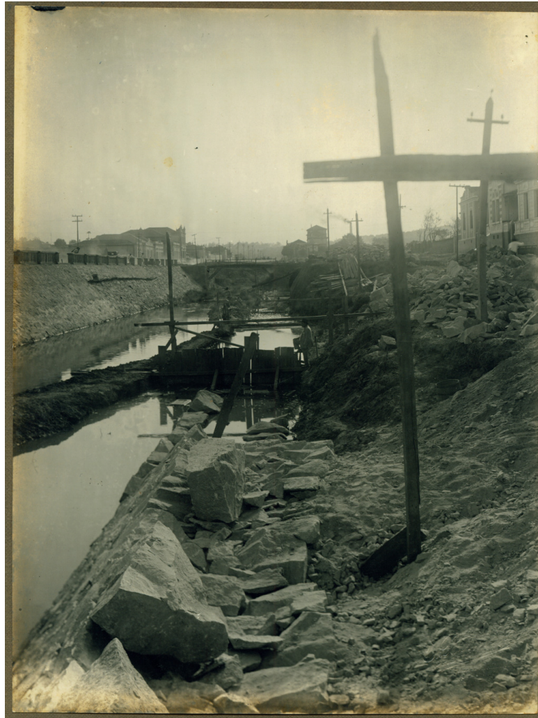
Figura 8: Canalização do Arrudas na Avenida Oyapock
