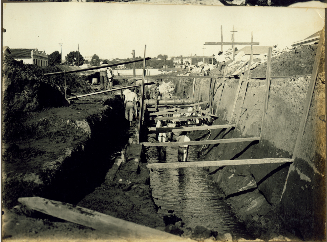
Figura 7: Canalização do Arrudas na Avenida Oyapock
