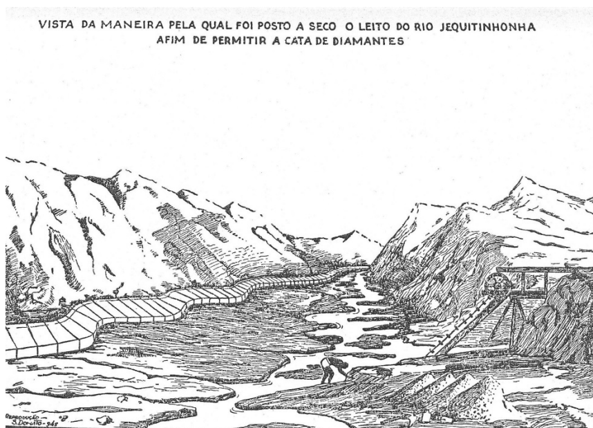
Figura 167: “Vista da maneira pela qual foi posto a seco o leito do rio Jequitinhonha a fim de permitir a cata de diamantes” (ESCHWEGE, [1833] 1979, vol1, p.139).
