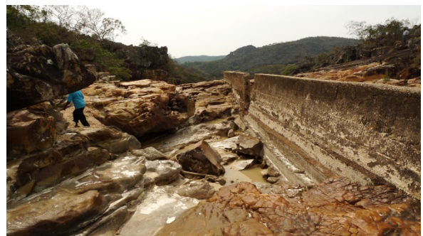
Figura 54: Vestígios do muro construído para virar o rio Caeté-mirim e secar a água do Funil (2 de outubro 2013).
