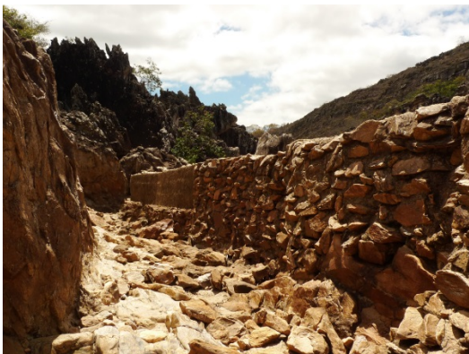
Figura 95: Muro de pedra construído para virar o rio. Foto de setembro de 2013.
