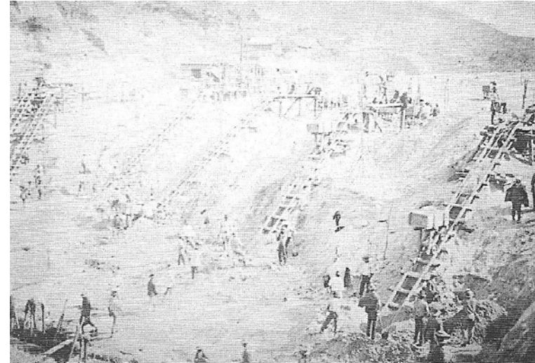
Legenda: "Esta foto da coleção de Derby mostra os planos inclinados sobre calhas de madeiras construídos para a exploração do diamante em Diamantina, Minas Gerais, no final do século XIX. (*MCT)" (TOSATTO, 2001, p. 65).
