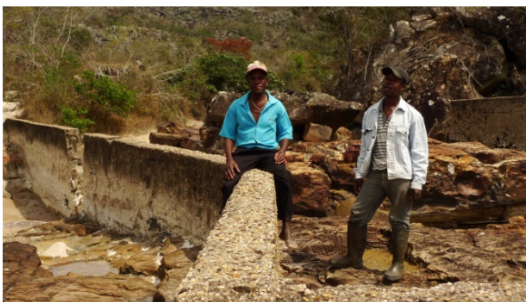
Figura 54: Vestígios do muro construído para virar o rio Caeté-mirim e secar a água do Funil (2 de outubro 2013).
