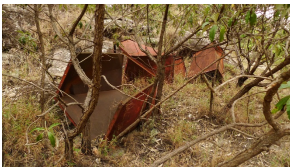
Figura 150: Restos da estrutura da bica ao lado da trilha de acesso ao Cânion do Funil. Setembro de 2013.
