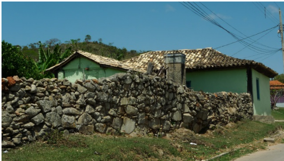
Figura 144: Muro de pedra em Costa Sena. Setembro de 2013.
