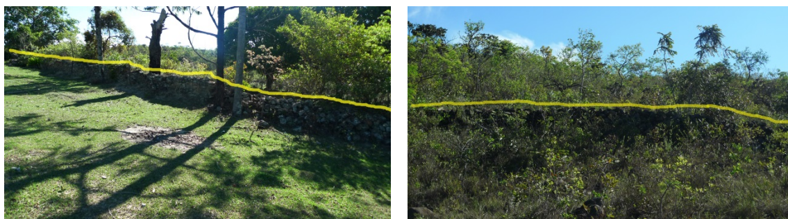
Figura 105: Muros de pedra de São Gonçalo das Canjicas. Foto de outubro de 2013.
