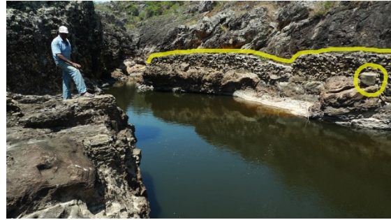
Figura 140: Poço dos Brant no rio Paraúna. Destaque em amarelo para o cimento e o muro para virar o rio. Setembro de 2013.
