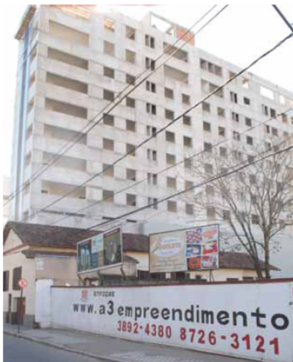
Duas das três grandes construções da A3 Empreendimentos, na Praça do Rosário
