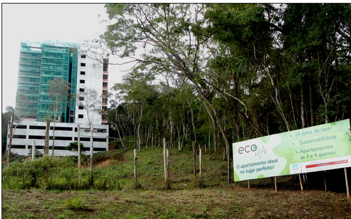
Figura 26: Condomínio em construção localizado entre o Paraíso e o campus da UFV (Foto: Silvano S. Dias, 2013).
