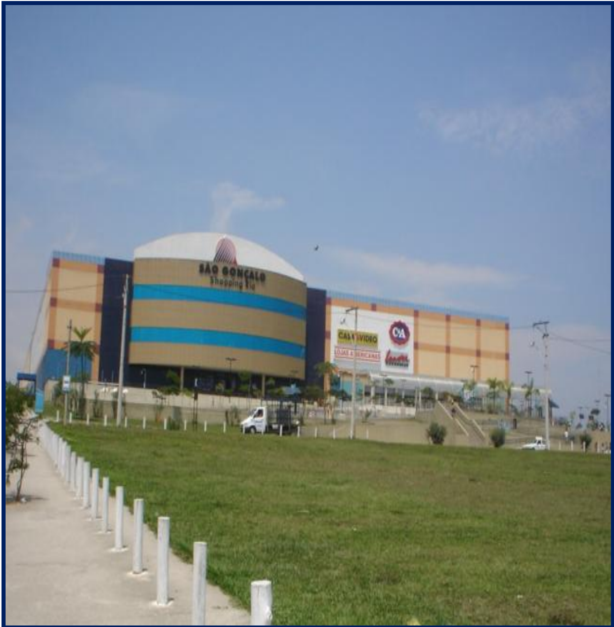
Figura 34 - Fachada principal do São Gonçalo Shopping Rio.
