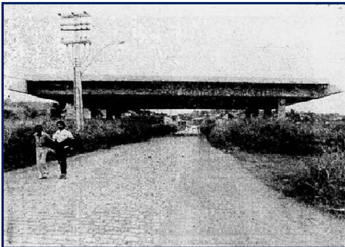
Figura 19 - Viaduto sobre antiga rua em São Gonçalo - RJ
