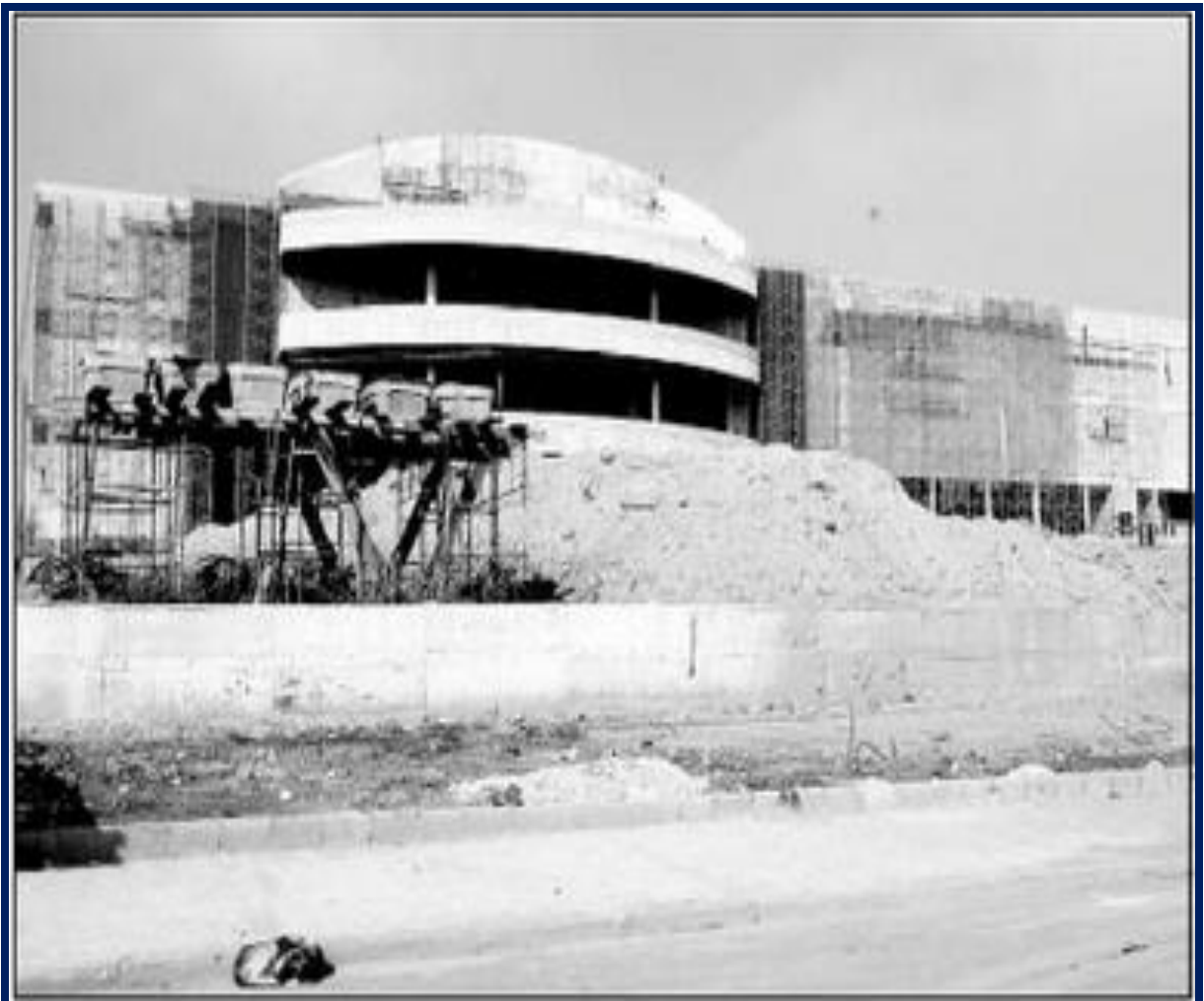
Figura 33 - Construção do São Gonçalo Shopping Rio
