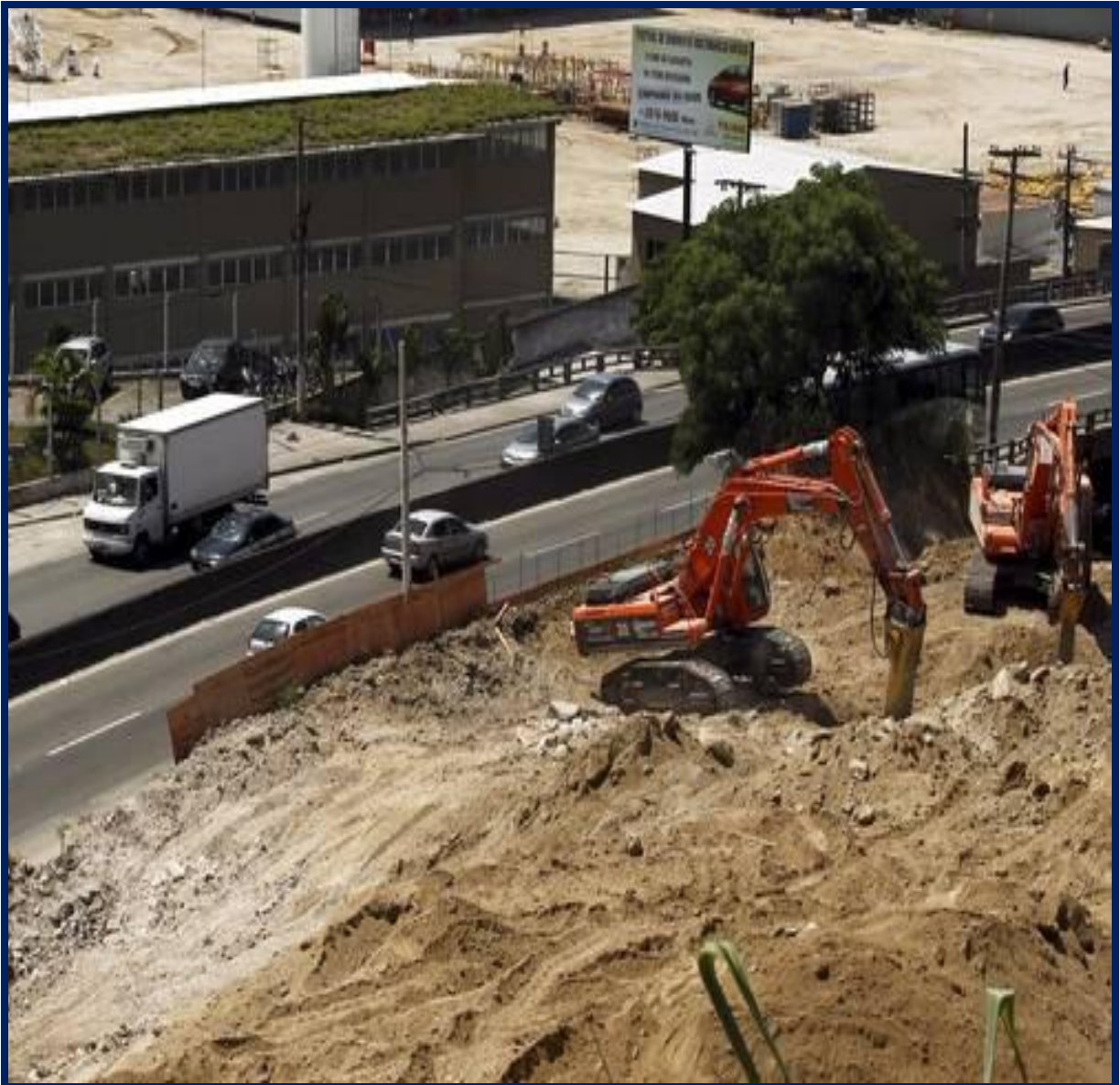
Figura 22 - Obra na Avenida do Contorno, BR-101.
