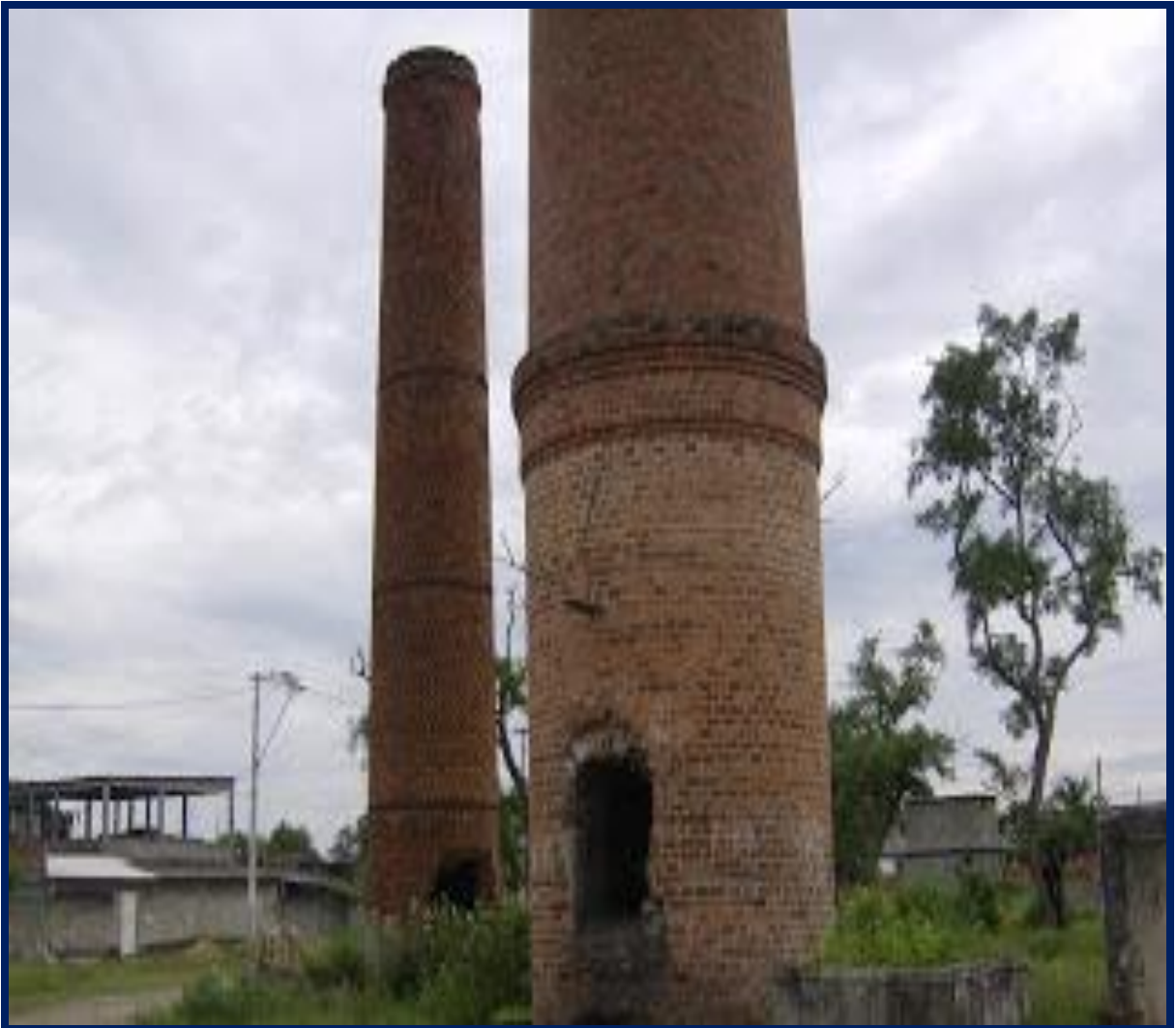
Figura 27 - Chaminés da antiga cerâmica Porto Rosa, 2007.
