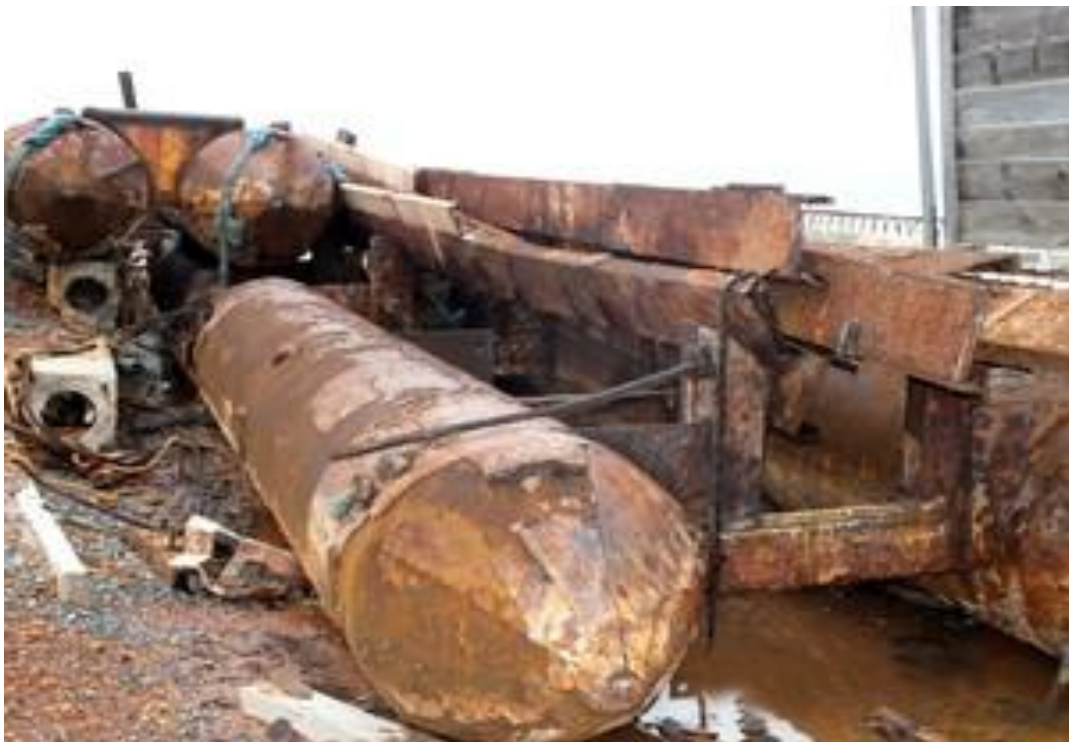
Figura 6 - Estado de conservação do porto de Luis Correia
