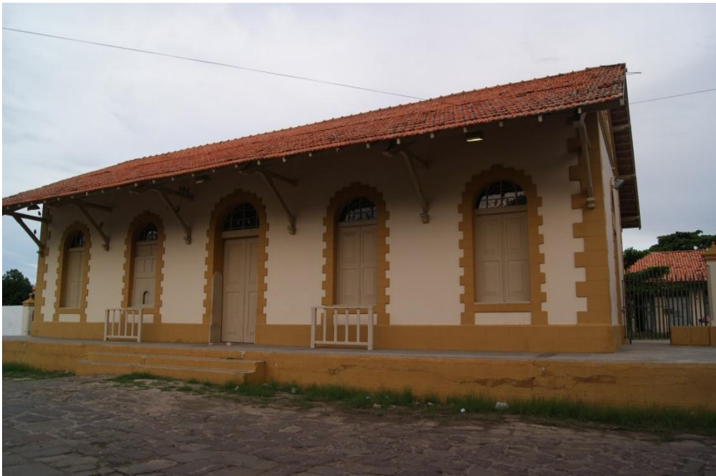
Figura 11 - Setor de bagagem da Estação de Parnaíba
