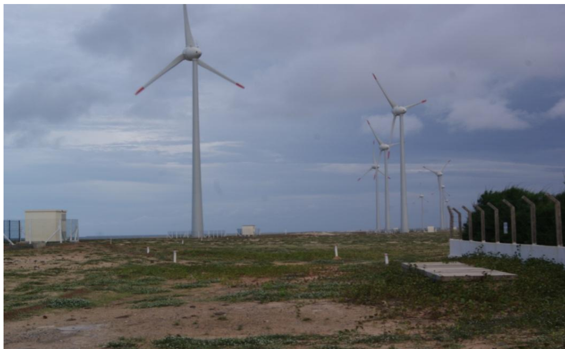
Figura 17 - Parque eólico da praia da Pedra do Sal Fonte: Majaci Moura da Silva (2011).
