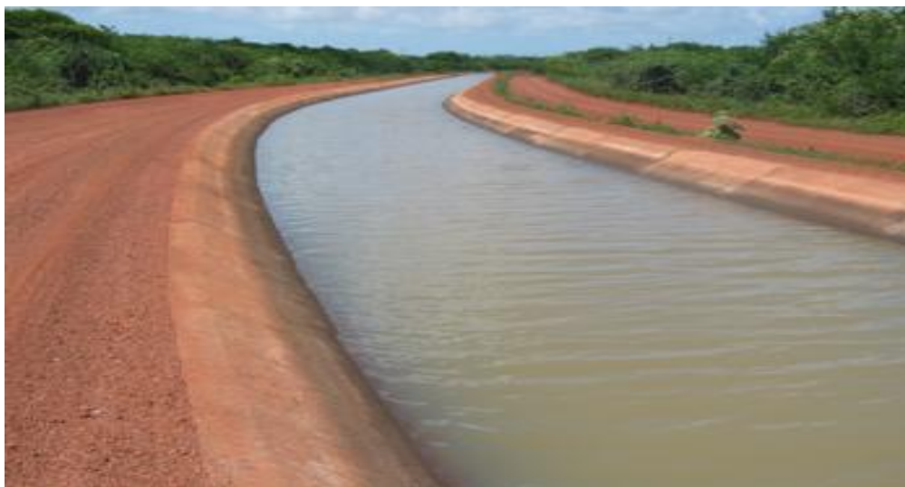
Figura 19 - Trecho de água canalizada dentro dos tabuleiros litorâneos Fonte: Majaci Moura da Silva (2012).
