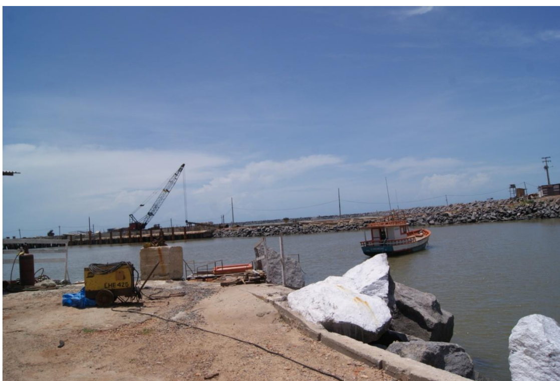
Figura 7 - Obras paralisadas do Porto de Luís Correia
