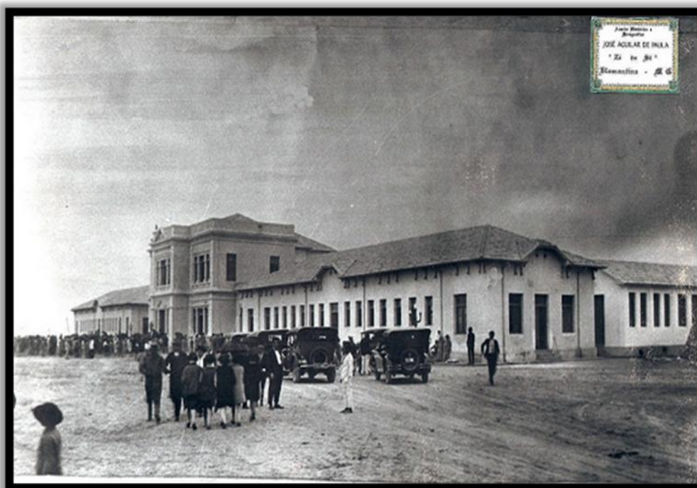
FIGURA 14: Prédio do quartel inaugurado em 1914 (Diamantina/MG).
