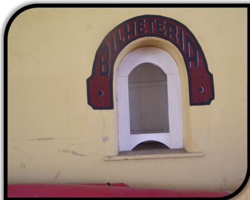
FIGURA 55: Bilheteria da antiga estação ferroviária (Diamantina/MG).
