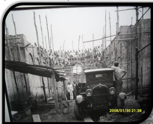
FIGURA 51: Construção da Catedral (Diamantina/MG).
