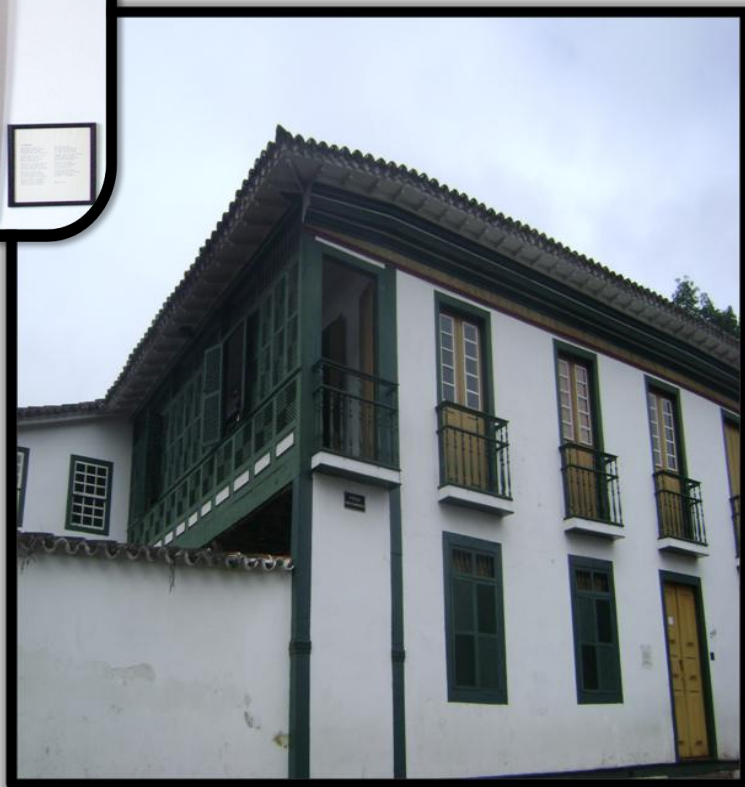
FIGURA 48: Fachada da residência da ex-escrava (Diamantina/MG).
