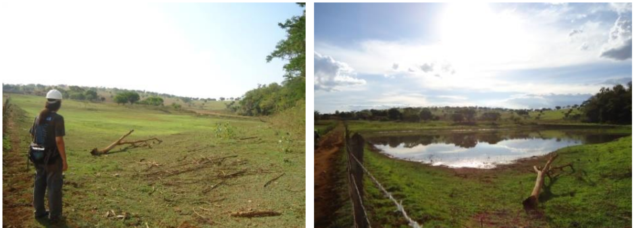
Figura 35 e 36. Dolina localizada na base do paredão do maciço do Limeira. A foto da figura 35 foi tirada na época seca e a foto da figura 36 na época chuvosa. Fotos: André Vasconcelos.
