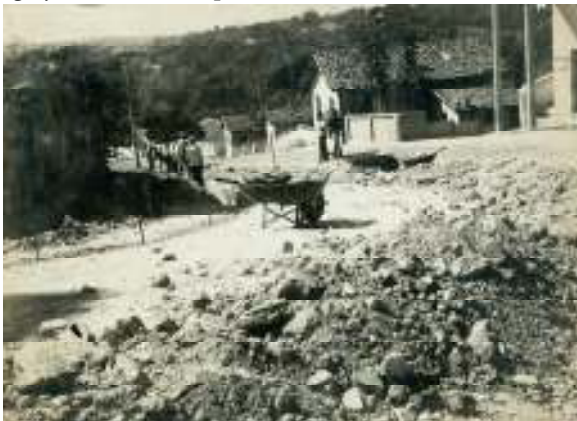
Obras de saneamento da R. Dr. Cassiano (dec. 60)
