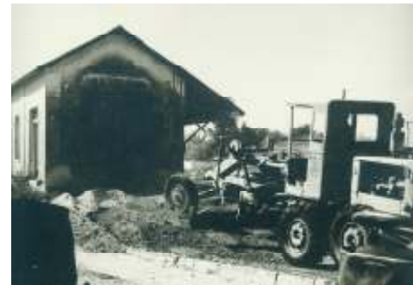
Demolição da Estação (1968)
