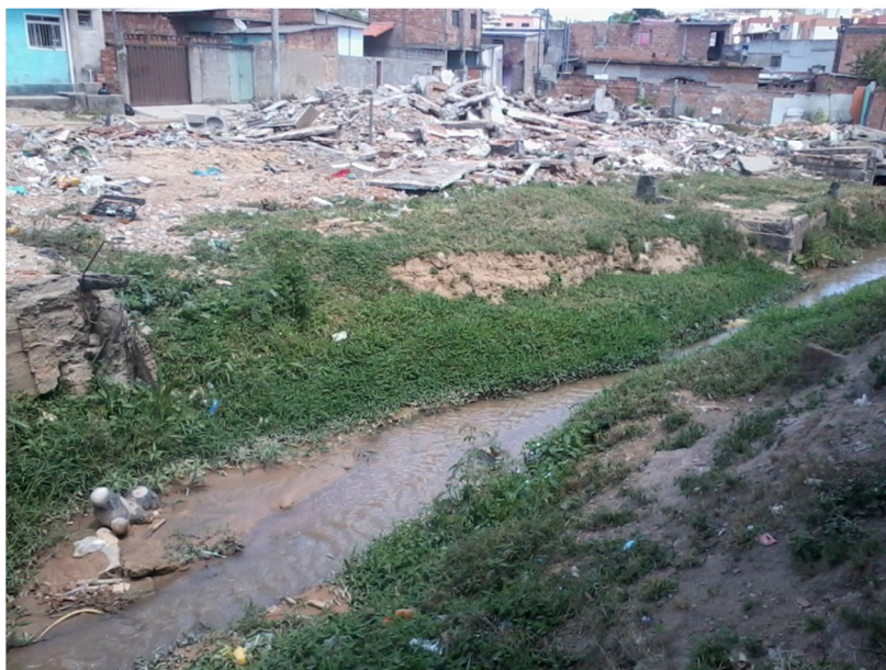
Figura 5: Casas demolidas em ocupação de fundo de vale na bacia do Córrego João Gomes, subafluente do Ribeirão Pampulha, para construção de Avenida Sanitária.
