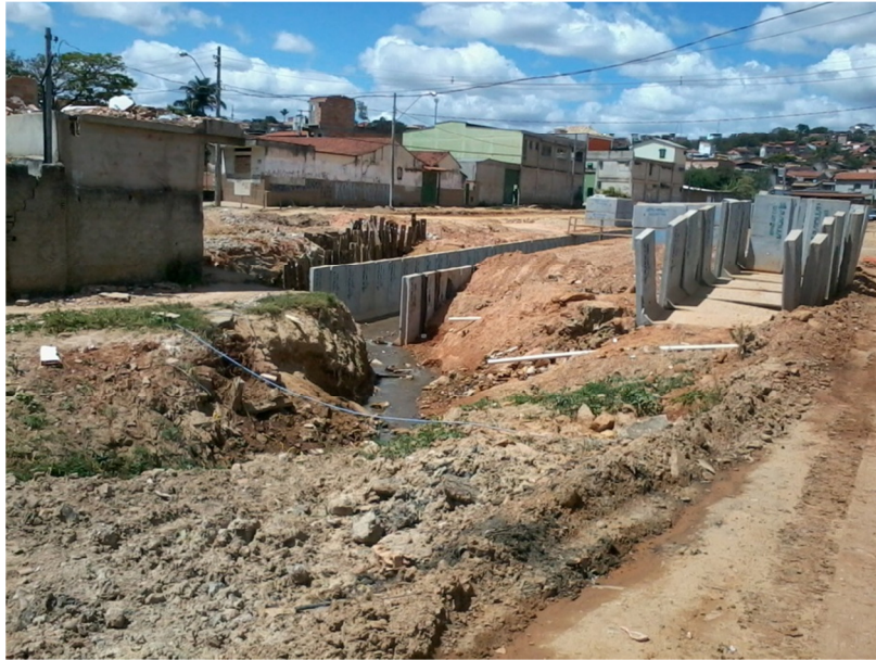
Figura 6: Canalização do Córrego João Gomes, Subafluente do Ribeirão Pampulha.
