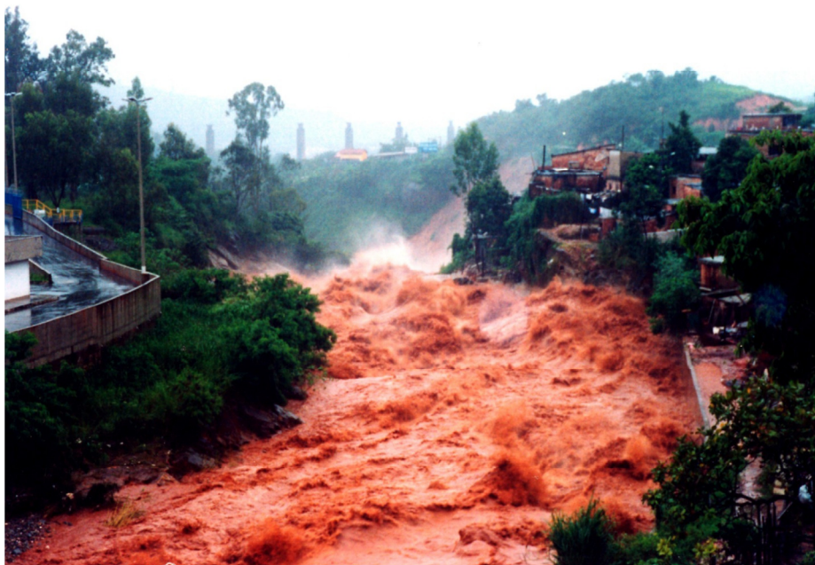
Figura 2: Vazão do Ribeirão Arrudas durante um pico hidráulico no limite de Belo Horizonte e Sabará. Fonte: acervo do Projeto Manuelzão, SD.
