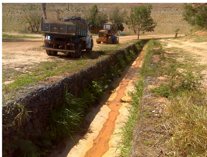
Figura 19: Ponto Ress_02, próximo ao aterro sanitário
