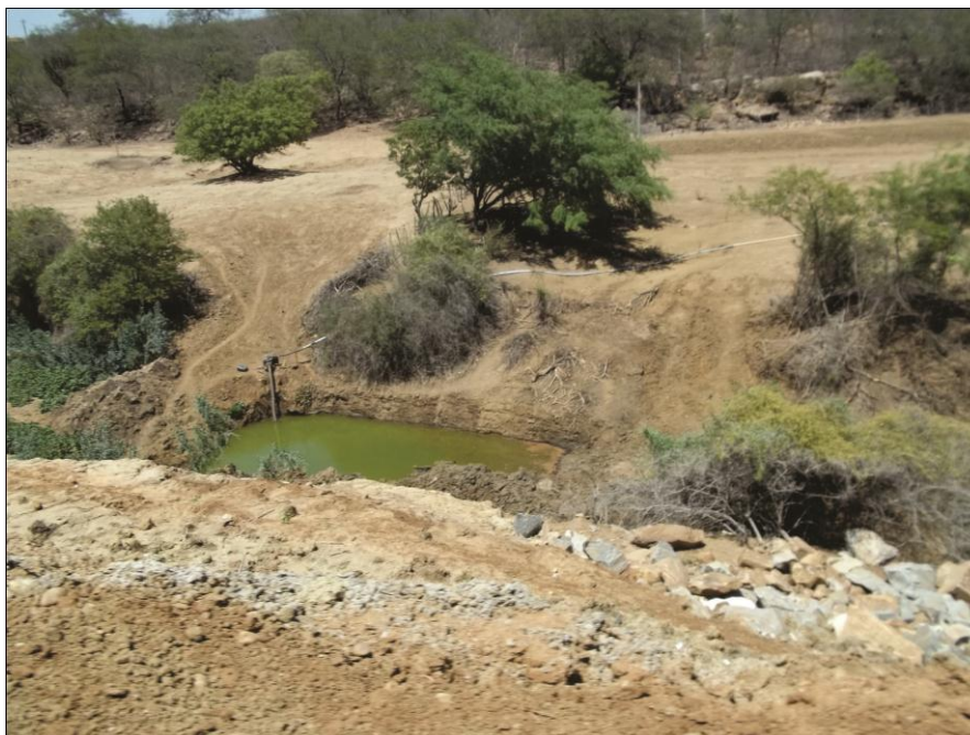
Foto 38. Rejeitos do canal da transposição invadindo uma cacimba.
