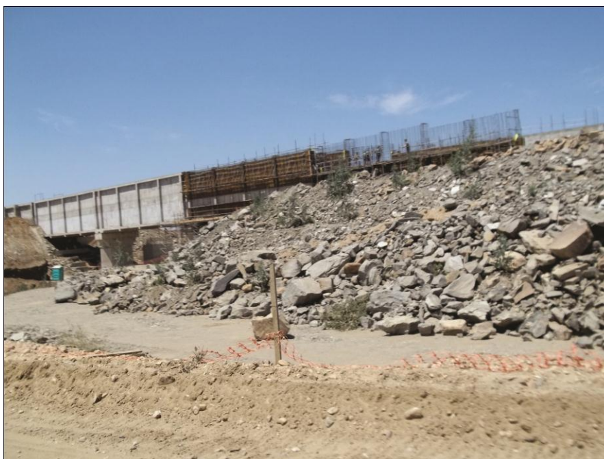
Foto 39. Aqueduto construído sob o riacho Grande. Ao lado, rejeito das obras da transposição sob o leito do riacho.
