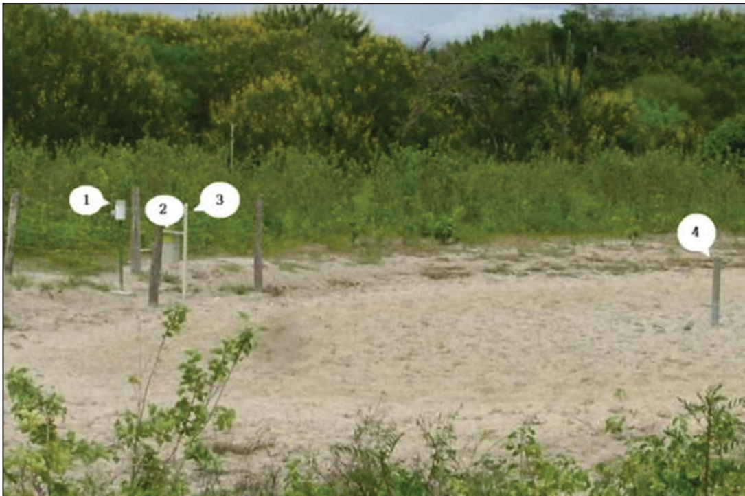
Figura 50 - Dolina Pedro Moura: 1- Pluviógrafo; 2- Caixa de armazenamento dos dados e o baro; 3 – Poço de monitoramento e 4 – Poço que permite o monitoramento do espelho d'água (Foto: Leticia Braga).
