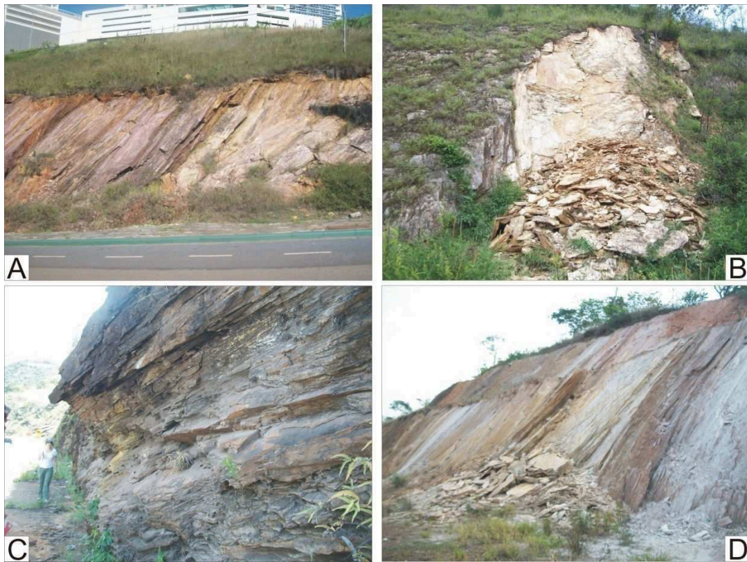
Figura 37 - Deslizamentos planares em maciços desconfinados na porção Sul: A. MES014 - 23K 610502 x 7789755 B. MES035 - 23K 623009 x 7798815 C. MES093 - 23K 613940 x 7788256 D. MES003 - 23K 622668 x 7784912.
