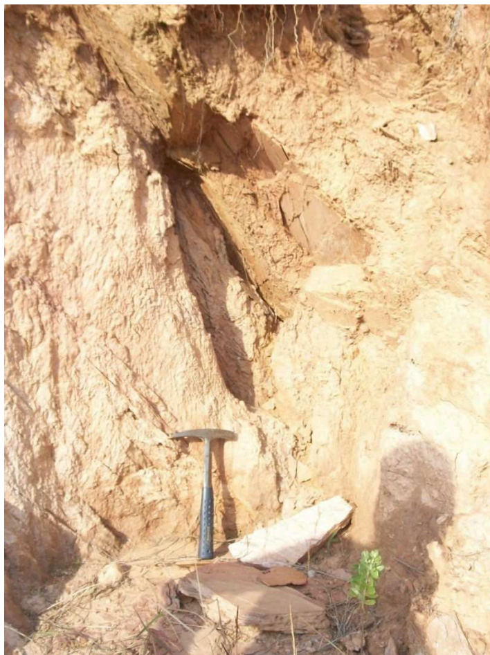
Figura 48 - Deslocamento em maciço de filito alterado (MES002 - 23K 610962 x 7788951)
