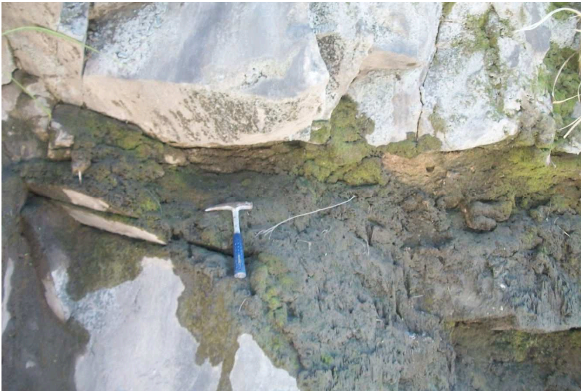
Figura 20 - Ocorrência de gotejamento e paredes úmidas em maciço de gnaiss do Complexo Belo Horizonte (MES023 - 23K 601929 x 7829749).
